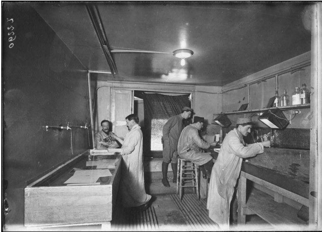
Εικόνα 16 - rue de Noisiel, Section photographique de l'Armée. Bureau des Archives rue de Noisiel, le laboratoire pour le développement, 1917 (Οδός Noisiel, S.P.A. Γραφείο Αρχείων στην οδό Noisiel, το εργαστήριο εμφάνισης, 1917). Μ.Α.Ρ./2008.
