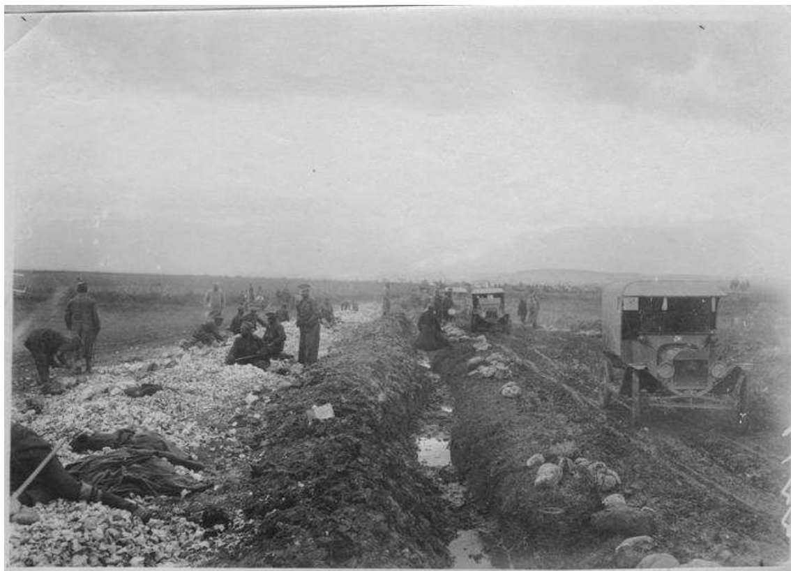
Εικόνα 34- Dans le secteur de Florina (octobre 1916). Prisonniers bulgares réparant les routes, 31/10/1916, Neokazi /Neokhorakion (Στον τομέα της Φλώρινας, Οκτώβριος 1916. Pow Βούλγαροι επιδιορθώνουν τον δρόμο, Νεοχωράκι). Μ.Α.Ρ./2008.
