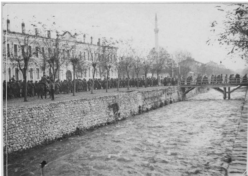
Εικόνα 11 - Arrivée des 1ères troupes françaises et russes à Monastir (19-22 novembre 1916). Convoi de prisonniers le long de la rivière, 19/11/1916, Opérateur V ; Bilowski (Αφιξη των πρώτων γαλλικών και ρωσικών στρατευμάτων στο Μοναστήρι, 19-22 Νοεμβρίου 1916. Νησομπή Ρωσ κατά μήκος του ποταμού). Μ.Α.Ρ./2008.
