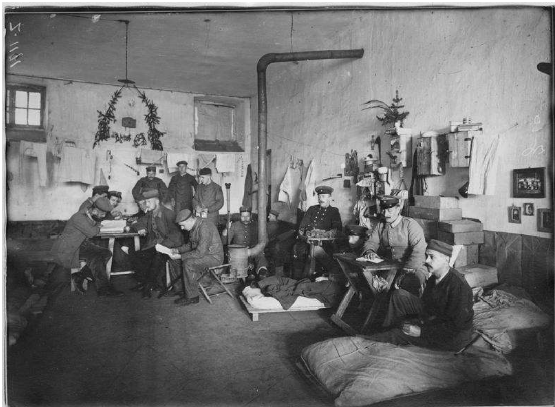
Εικόνα 5 - Dépôt de prisonniers. Salle des blessés, 26/12/1916, Romans-sur-Isère (Τόπος φυλάκισης Ρow. Δωμάτιο τραυματιών). Μ.Α.Ρ./2012.
