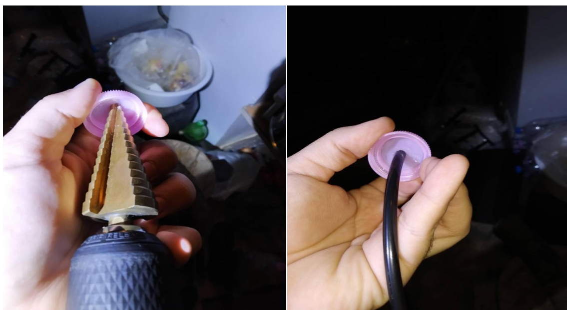
Σχήμα 3.5 Διάτρηση και σωλήνωση
