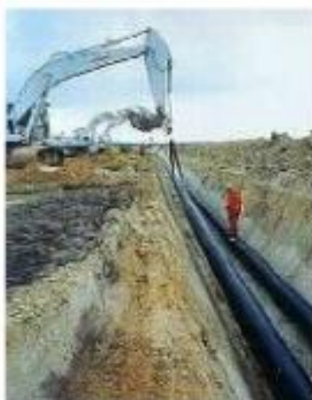
Εικόνα 2.6.3 Δίκτυο διανομής τηλεθέρμανσης
