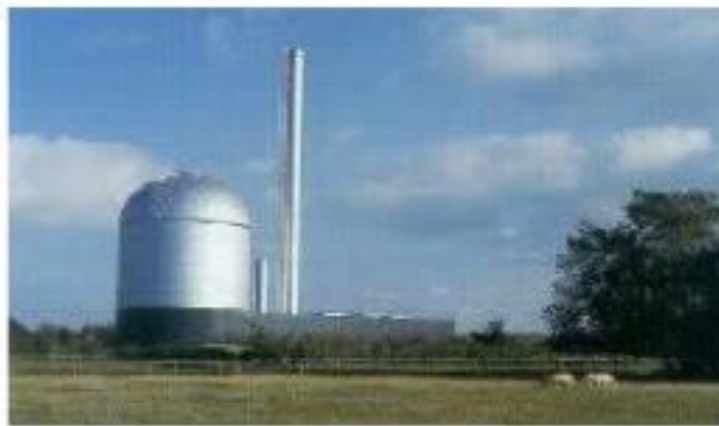
Εικόνα 2.6.2 Κεντρικός σταθμός παραγωγής ενέργειας
