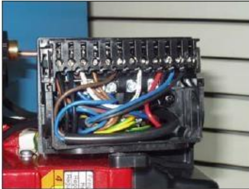
Εικόνα 2.1.1.3 Βάση Ηλεκτρονικού από καυστήρα πετρελαίου
