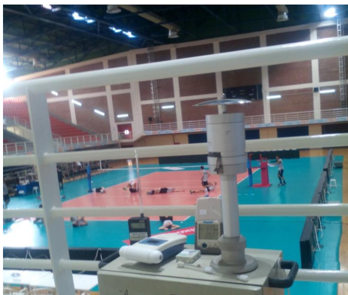
Εικόνα 13: Εγκατεστημένα όργανα μέτρησης συγκέντρωσης \text{NO}_2 και \text{O}_3 .
