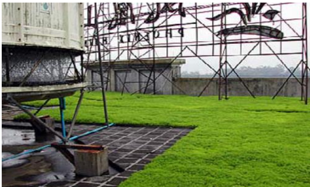
Εικόνα 19: Χαρακτηριστικό παράδειγμα εκτατικής πράσινης στέγης
