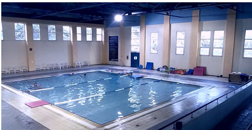
Εικόνα 5.13: Εσωτερικός χώρος πισίνας εκμάθησης.
