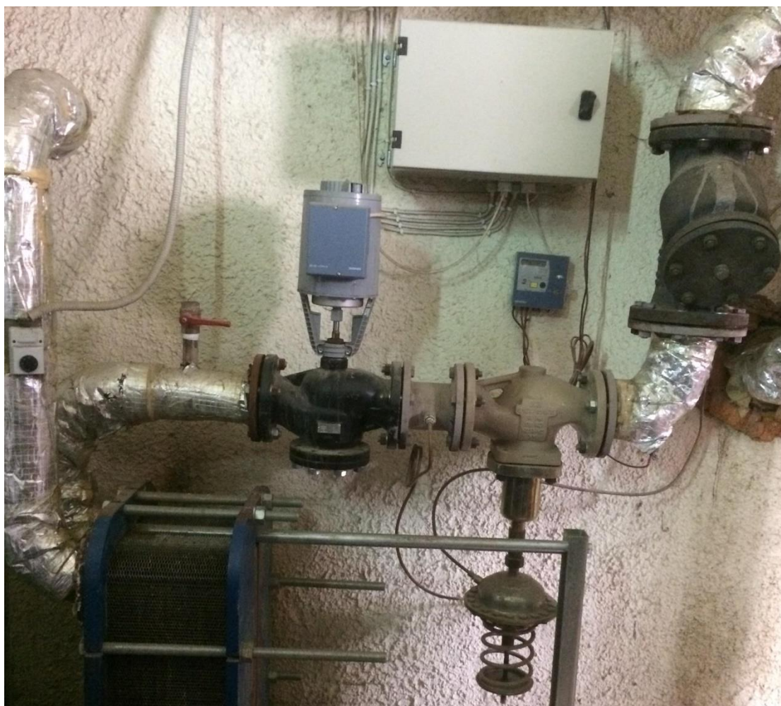
Εικόνα 5.4: Εναλλάκτης Τηλεθέρμανσης.
