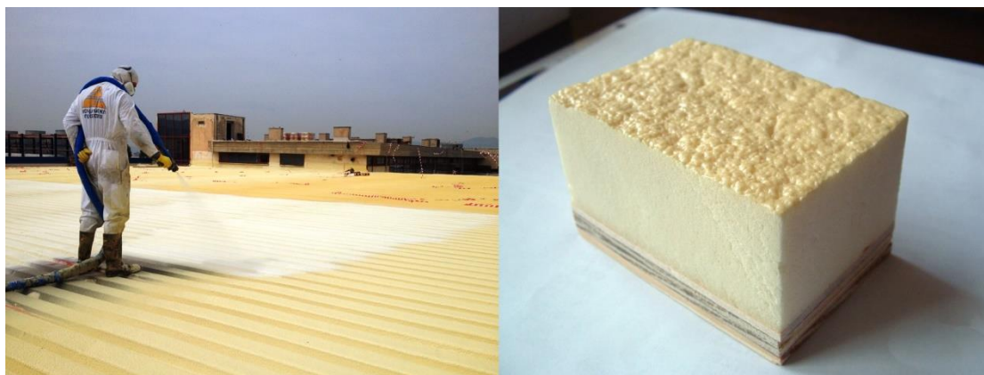
Εικόνα 7.1: Διεργασία τοποθέτησης αφρού πολυουρεθάνης και αποτέλεσμα αυτού.
