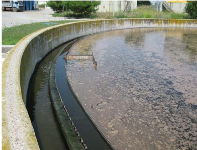
Σχήμα 6: Δεξαμενή δευτεροβάθμιας καθίζησης
