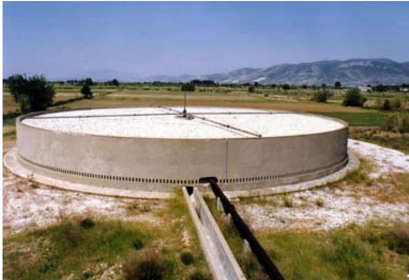
Σχήμα 3: Κυκλική δεξαμενή πρωτοβάθμιας καθίζησης
