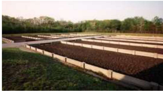
Σχήμα 10: Κλίνες ξήρανσης
