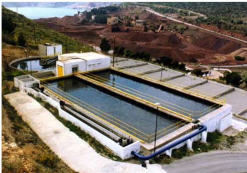
Σχήμα 4: Ορθογώνια δεξαμενή πρωτοβάθμιας καθίζησης
