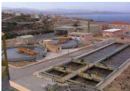
Σχήμα 5: Βιοαντιδραστήρας δευτεροβάθμιας επεξεργασίας
