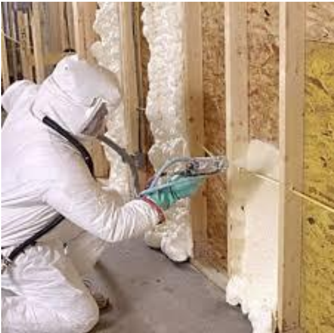
Σχήμα 4.11: Τοποθέτηση αφρού πολυουρεθάνης [ www.polyurethane.myewebsite.com ]
