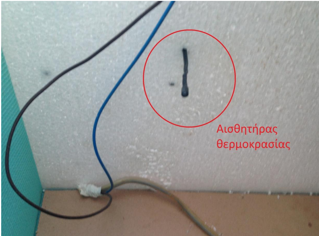
Σχήμα 6.6: Άνοιγμα οπής και τοποθέτηση του αισθητήρα της θερμοκρασίας
