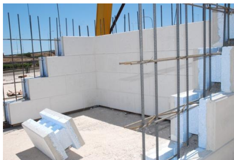
Σχήμα 3.5: Δομικό μπλοκ εξωτερικού τοίχου [www.sparailias.gr]
