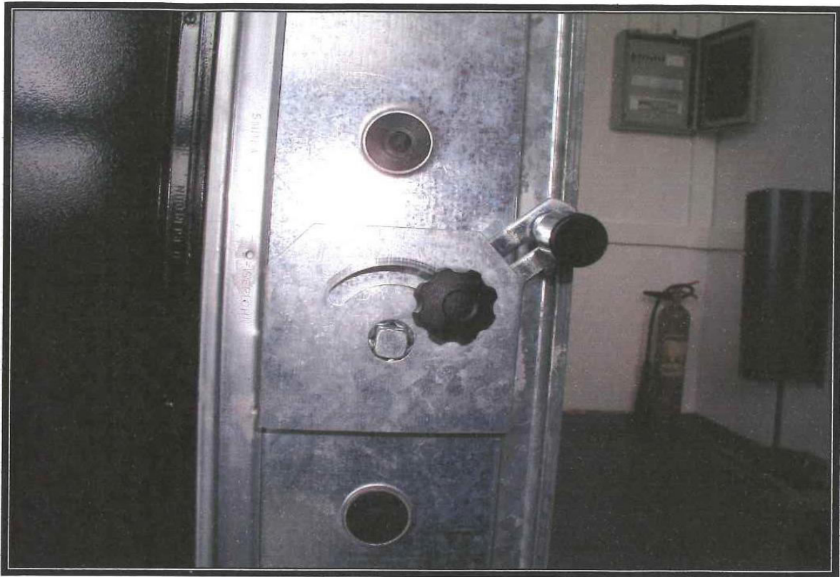
Εικόνα 2.9 : Ο μοχλός με τον οποίο ανοίγουν και κλείνουν οι ρυθμιστές.
