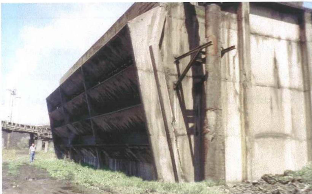
Σχήμα 33 Η εγκατάσταση των πύργων ψύξης της μονάδας του ΑΗΣ ΛΙΠΤΟΛ (1)
