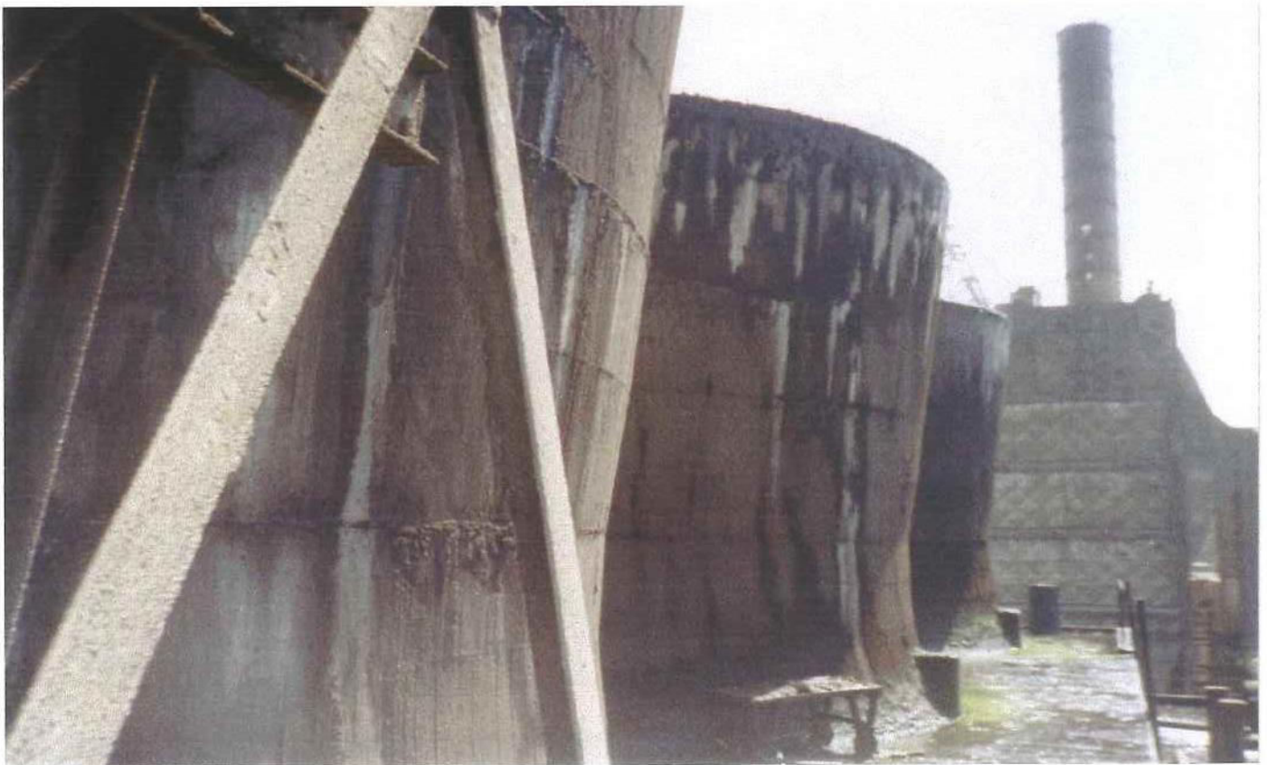
Σχήμα 37 Το κατάστρωμα των πύργων ψύξης της μονάδας του ΑΗΣ ΛΙΤΠΤΟΛ (2)
