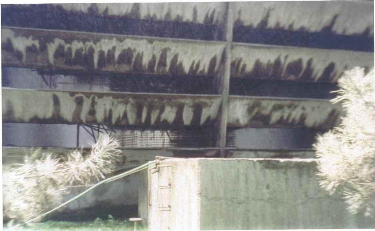
Σχήμα 38 Το κατεστραμμένο πληρωτικό υλικό σε ένα από τα έξι κελιά των πύργων ψύξης της μονάδας του ΑΗΣ ΛΙΠΤΟΛ (1)
