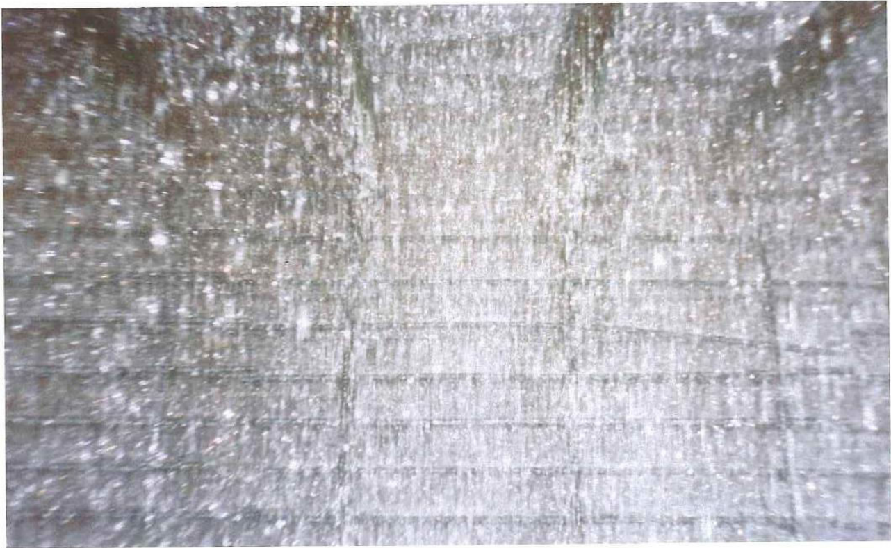
Σχήμα 40 Στα κελιά όπου το πληρωτικό υλικό δεν έχει υποστεί ζημιές ο διασκορπισμός του νερού γίνεται με επιτυχία
