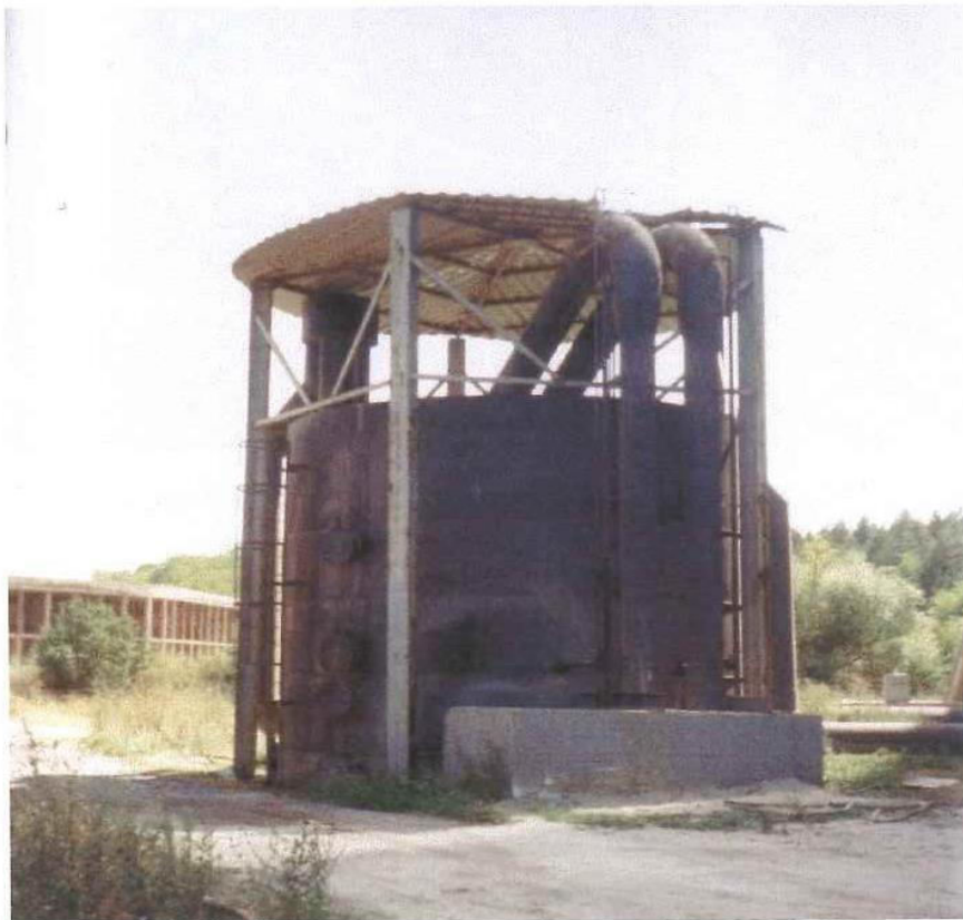
Σχήμα 15 Πραγματική διάταξη φίλτρων βαρύτητας στον ΑΗΣ Πτολεμαΐδας
