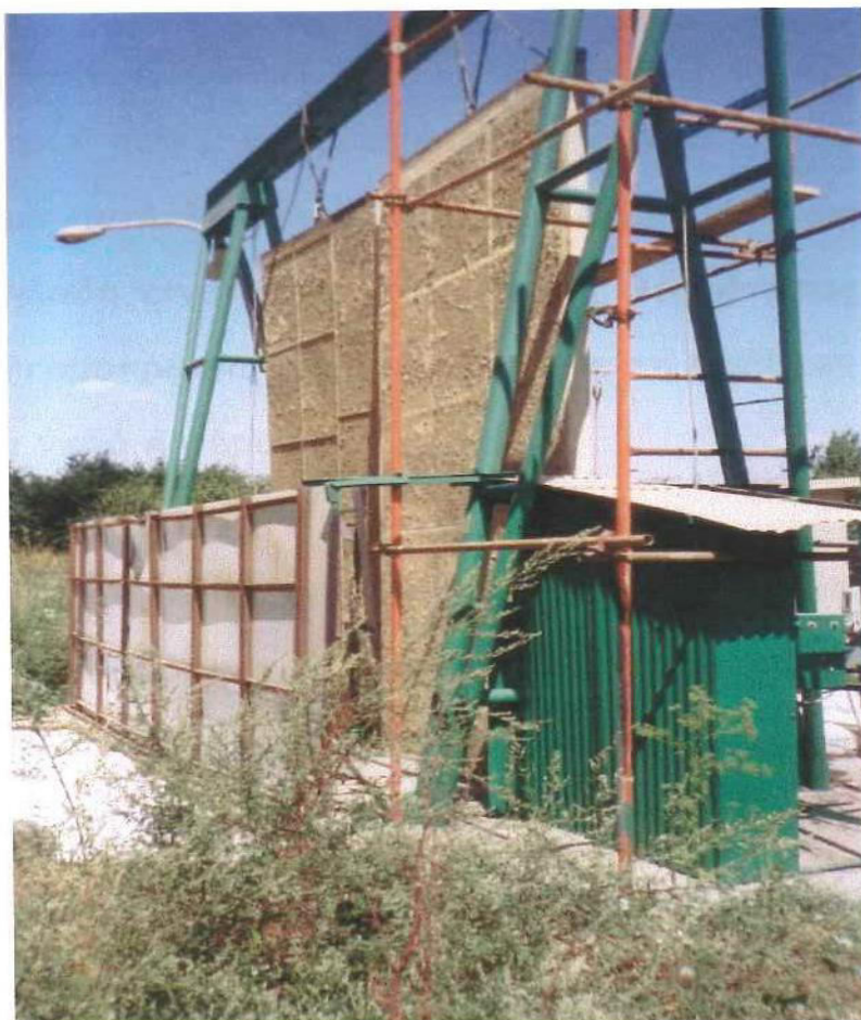
Σχήμα 17 Πραγματική διάταξη σιτών αναρρόφησης στον ΑΗΣ Πτολεμαΐδας
