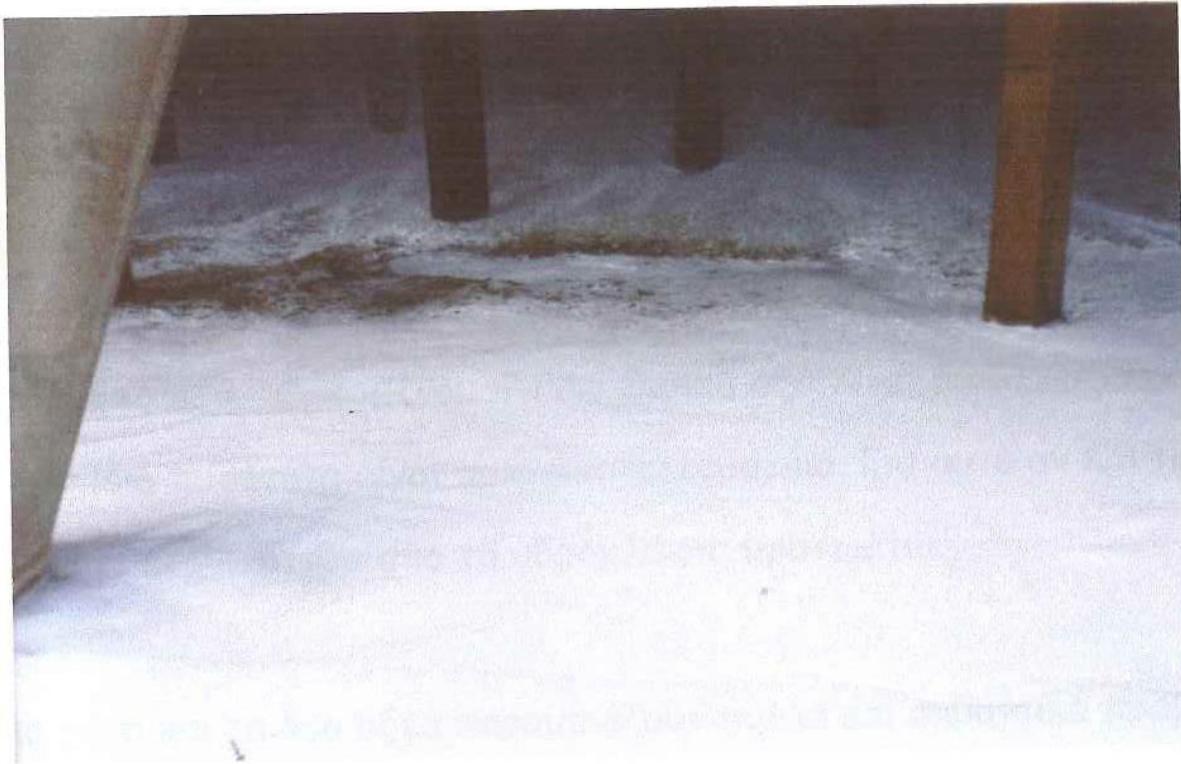
Σχήμα 42 Φωτογραφία από τη λεκάνη πύργου ψύξης την χρονική περίοδο «σοκαρίσματος» του συστήματος με διασπαρτικές χημικές ουσίες
