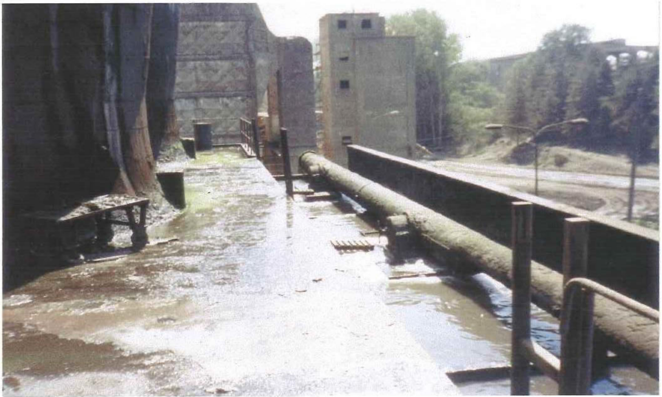
Σχήμα 36 Το κατάστρωμα των πύργων ψύξης της μονάδας του ΑΗΣ ΛΙΤΠΤΟΛ (1)
