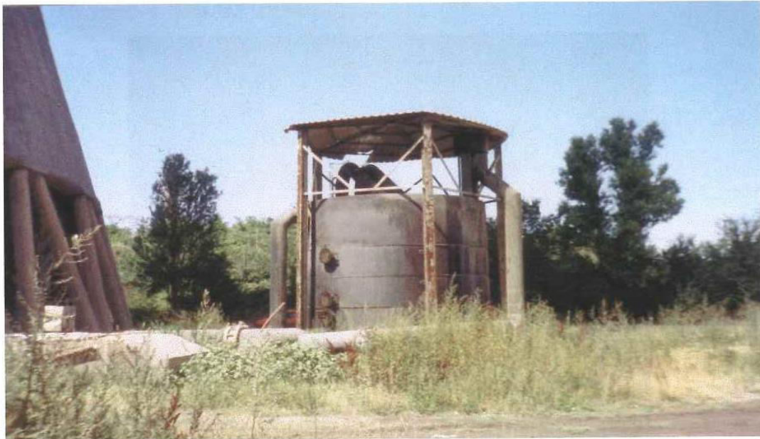
Σχήμα 16 Πραγματική διάταξη φίλτρων βαρύτητας στον ΑΗΣ Πτολεμαΐδας - Προσαγωγή νερού
