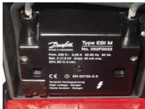
Εικόνα 2.5 Μετασχηματιστής καυστήρα
