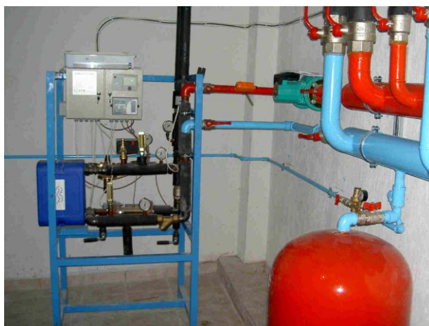
Εικόνα 2.45 Υποσταθμός κτιρίου
