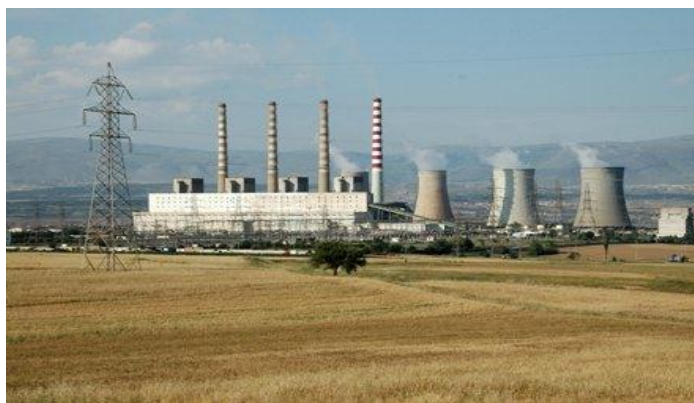
Εικόνα 2.43 Κεντρικός σταθμός παραγωγής ενέργειας
