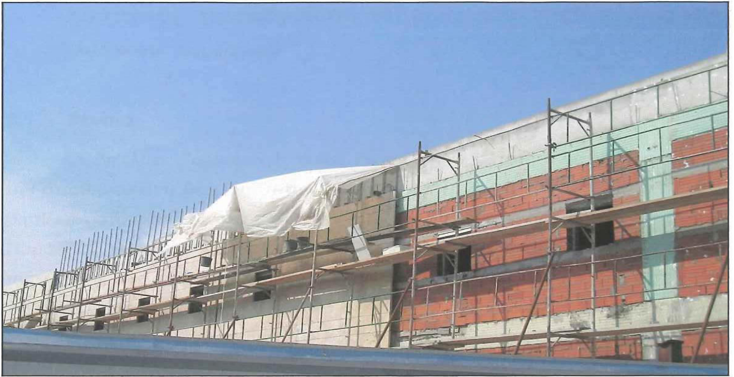
Εικόνα 2.5. Μακρινή εικόνα της δικέλυφης όψης κατά την κατασκευή της
