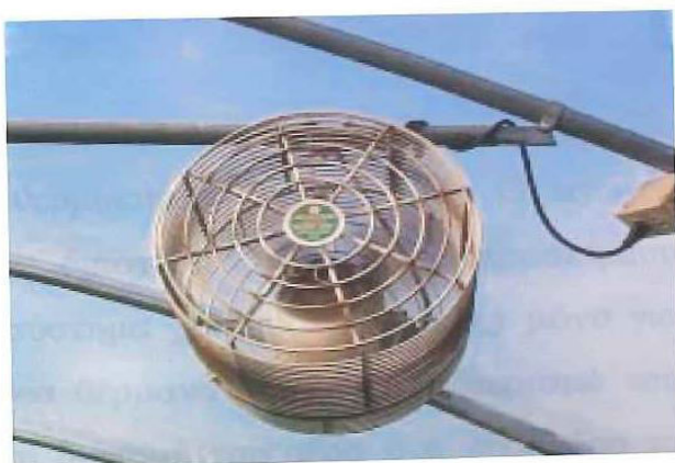
Σχήμα 5.2: Ανεμιστήρας οριζόντιας ροής αέρα.
