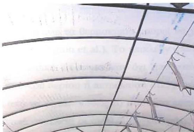
Σχήμα 2.2: Προβλήματα συμπύκνωσης λόγω υψηλών επιπέδων υγρασίας.
