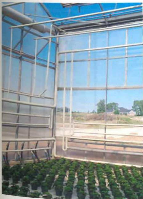
Σχήμα 3.15 (αριστερά) και 3.16 (δεξιά): Τοποθέτηση του θερμαντικού συστήματος στην οροφή του θερμοκηπίου.
