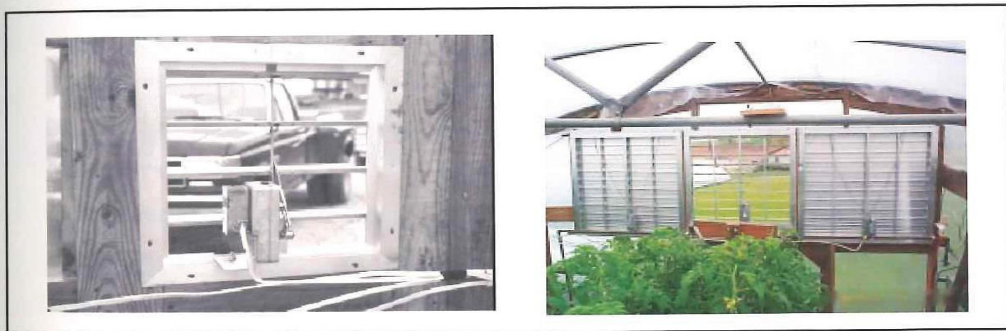
Σχήμα 4.4: Γρίλιες για είσοδο του αέρα στο χώρο.
