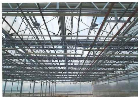
Σχήμα 3.15 (αριστερά) και 3.16 (δεξιά): Τοποθέτηση του θερμαντικού συστήματος στην οροφή του θερμοκηπίου.
