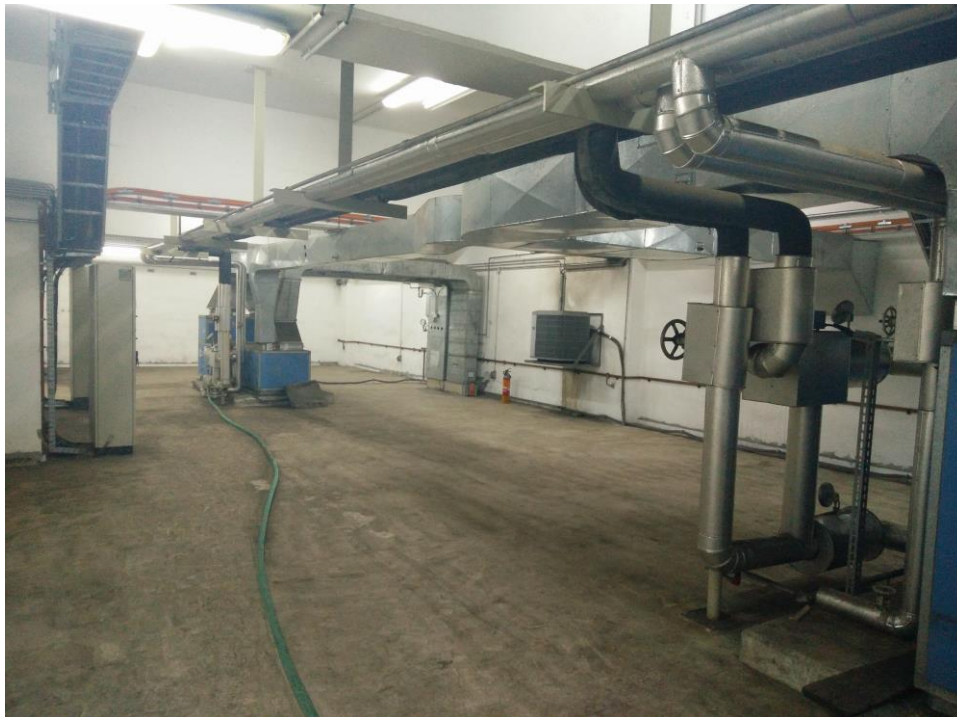
Εικόνα 3.4 Σύστημα Αποκονίωσης
