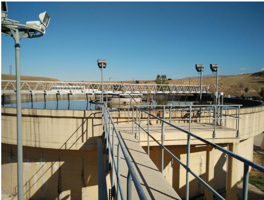
Εικόνα 4.3 Κιγκλιδώματα ενός μέτρου - Προβολείς
