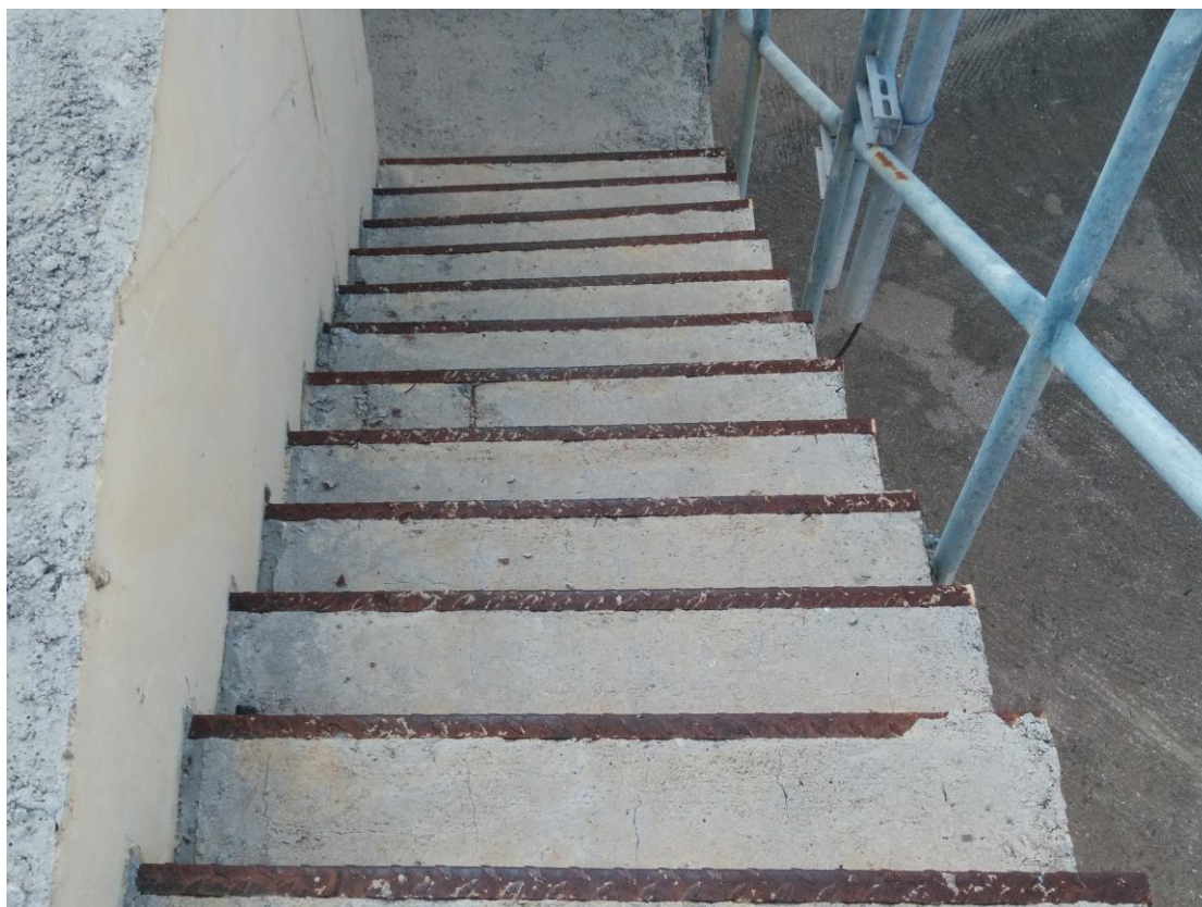
Εικόνα 4.5 Σκάλες εξωτερικού χώρου
