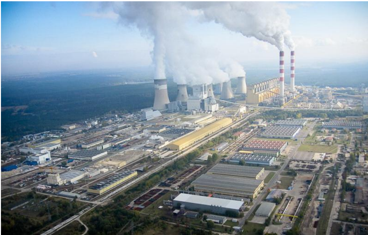
Σχήμα 1.2: Ατμοηλεκτρικός Σταθμός Belchatow (Πηγή: Wikipedia [4])
