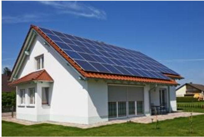
Εικόνα 1.12: Φωτοβολταϊκά σε Μονοκατοικία
