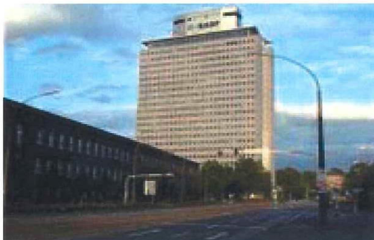
Εικόνα 1. Το εργοστάσιο της Basf στη Γερμανία [2]
