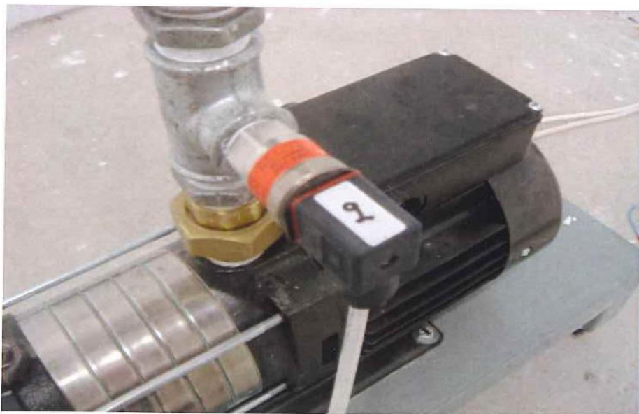
Εικόνα 5: Μεταδότης πίεσης DANFOSS MBS-3000 μετά την αντλία
