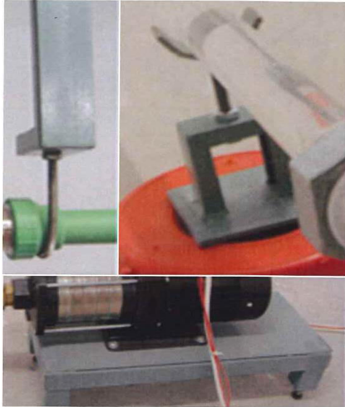
Εικόνα 12: Βάση αντλίας, στηρίγματα δαπέδου και ταβανιού
