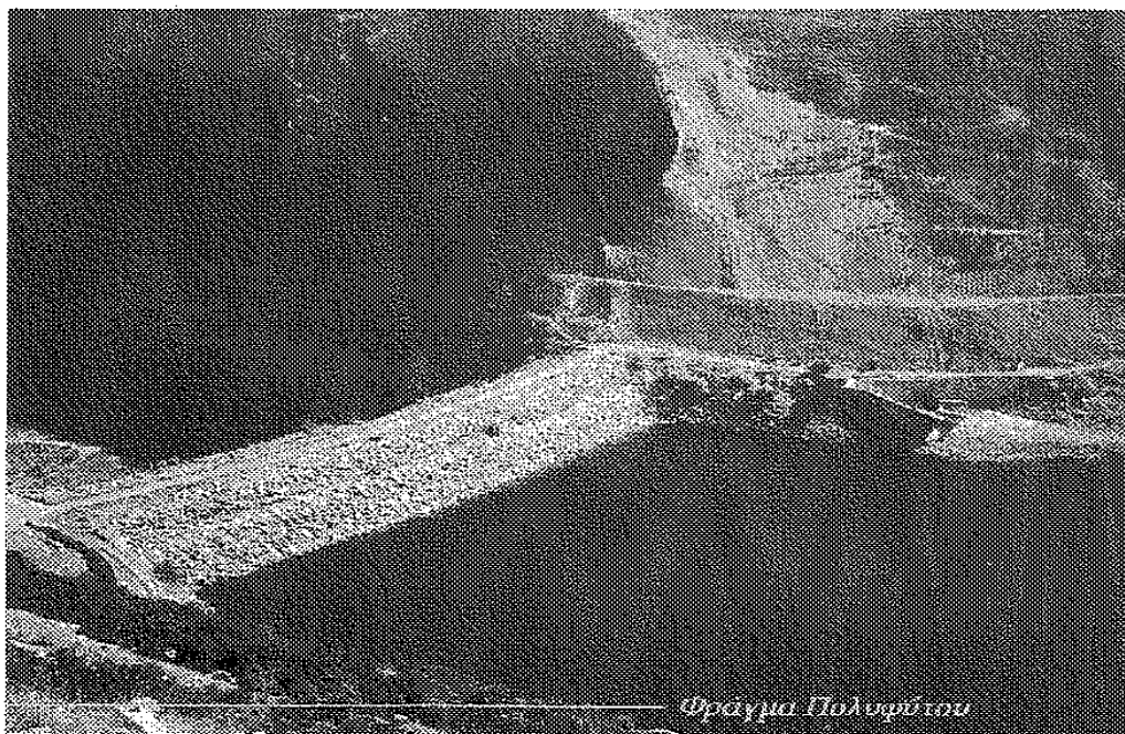
Εικόνα 2.2. Το Φράγμα του Πολυφύτου [17]
