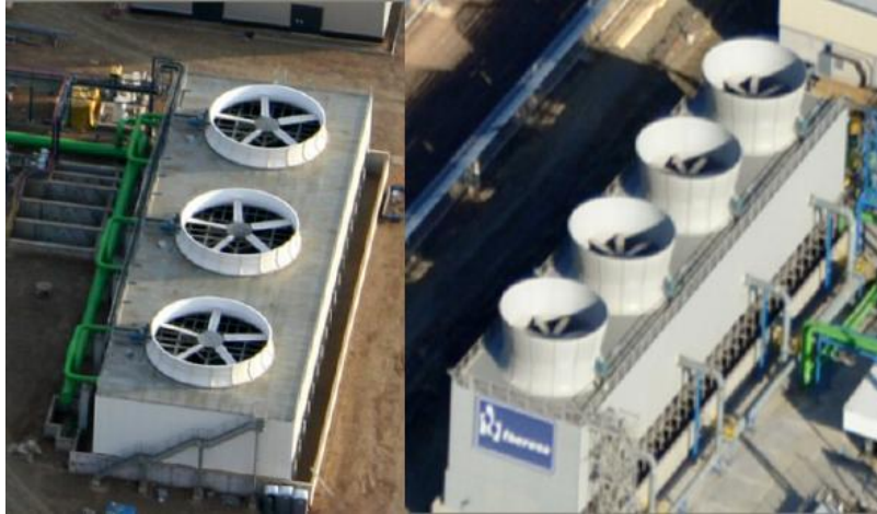
Εικόνα 10: Πύργοι ψύξης τριών και τεσσάρων στοιχείων [19]
