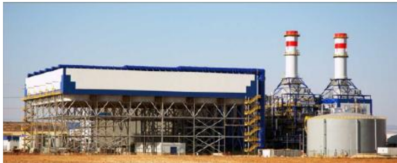
Εικόνα 11: Αεροσυμπυκνωτής [19]
