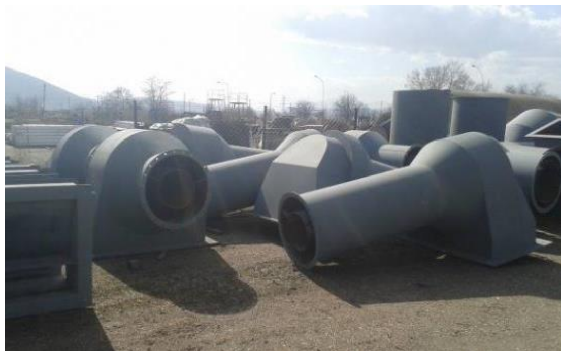
Εικόνα 34:εργασίες βαψίματος αγωγών (ΟΦΑ)
