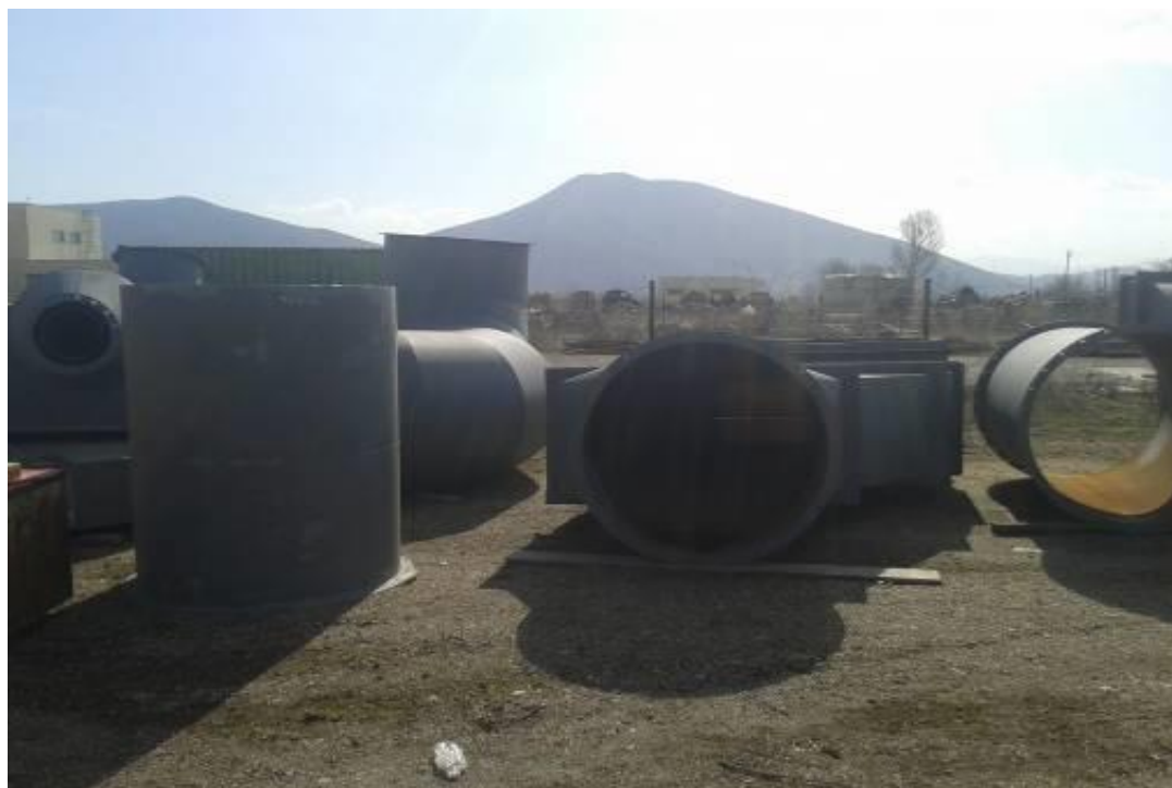
Εικόνα 32: εργασίες συναρμολόγησης αγωγών (PFDructs)
