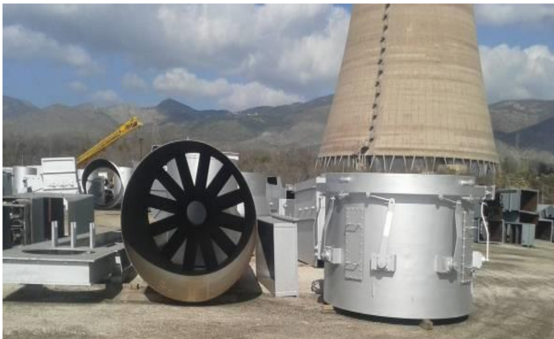
Εικόνα 33:εργασίες συναρμολόγησης αγωγών εξαερισμού
