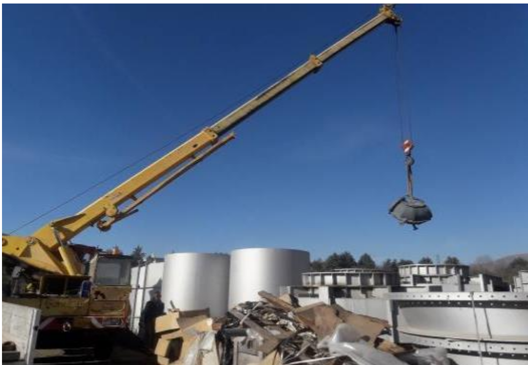
Εικόνα 37: εργασίες ανύψωσης αεραγωγών
