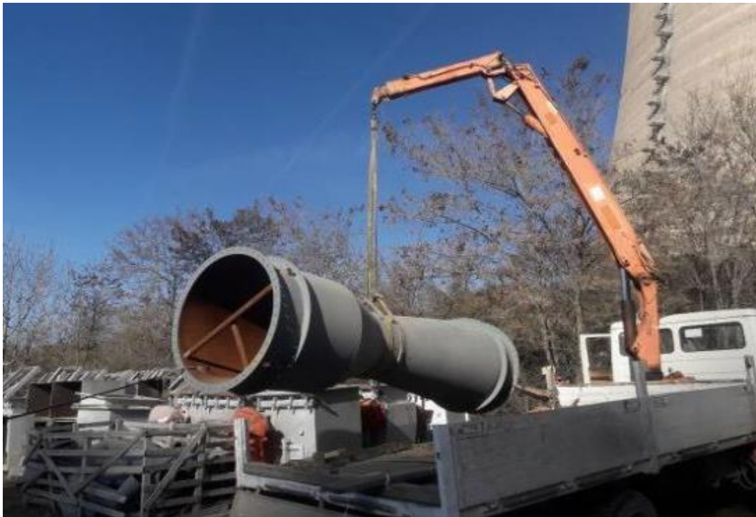
Εικόνα 36: εργασίες ανύψωσης αγωγών (PF Ducts)
