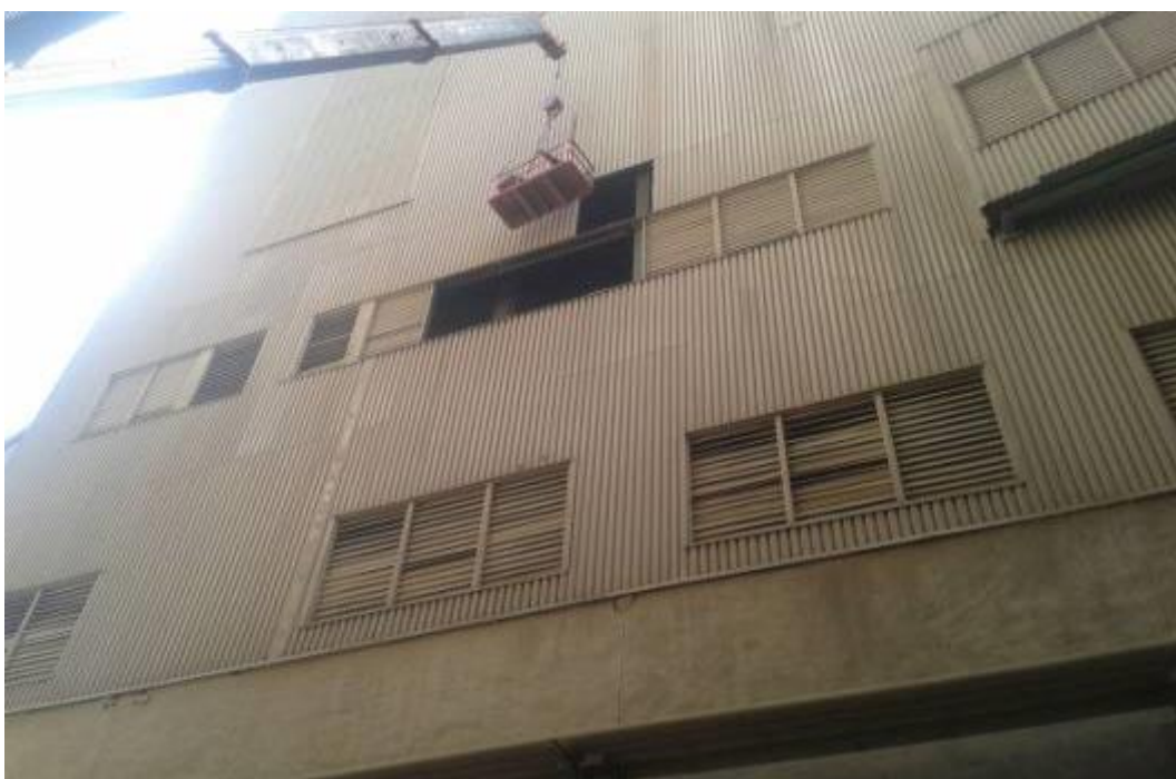
Εικόνα 38:εργασίες ανύψωσης υλικών
