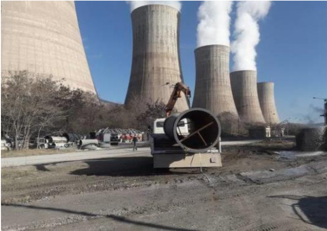
Εικόνα 35:εργασίες μεταφοράς αγωγών (PF Ducts)
