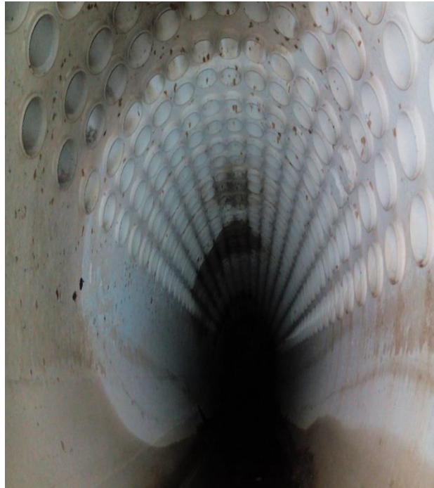
Σχήμα 66: Αυλοί όπως φαίνονται από κάτω ανθρωποθυρίδα
