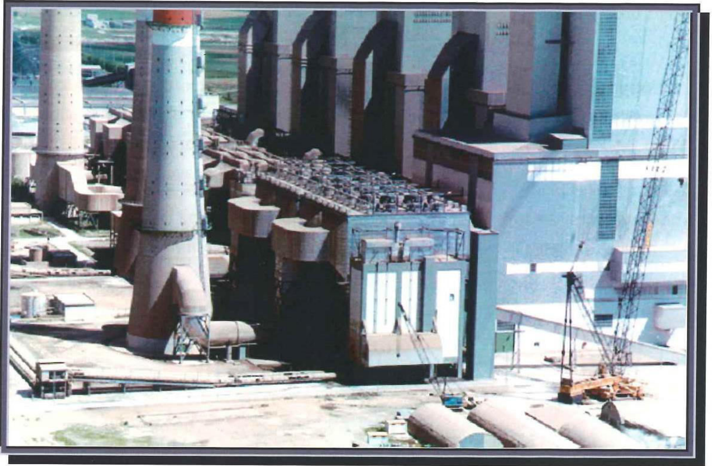
Εικόνα 6 : Ηλεκτροστατικά φίλτρα
