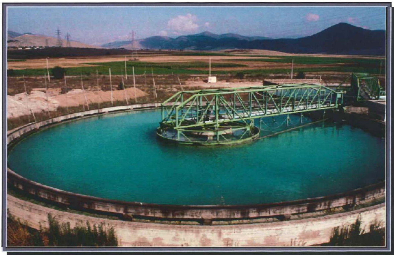
Εικόνα 7 : Δεξαμενή καθίζησης
