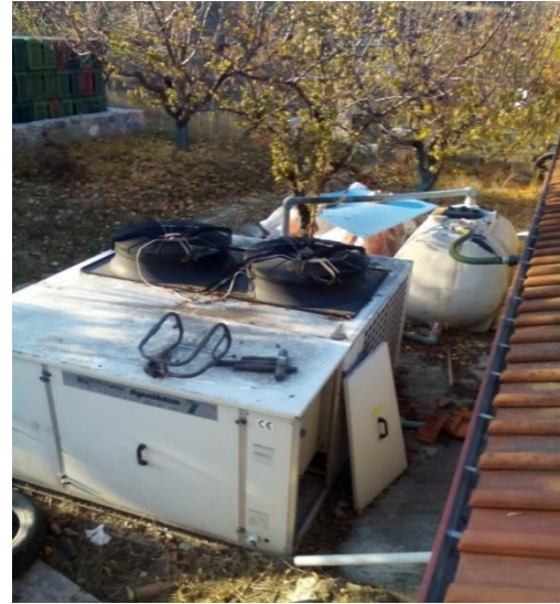
Εικόνα 3.3 Συμπιεστής για παραγωγή ψύξης.
