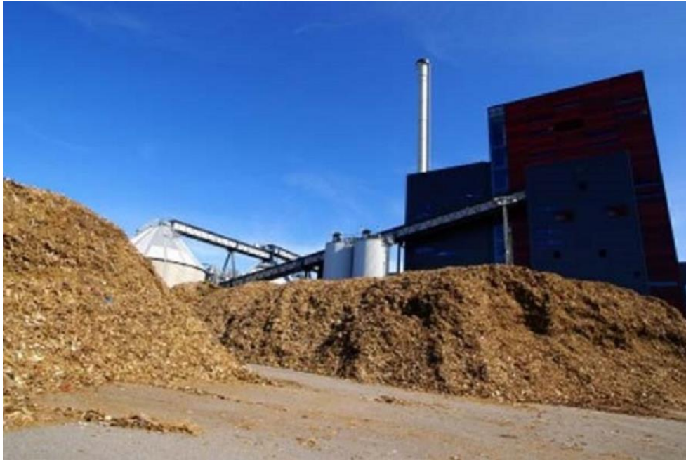
Εικόνα 6.5 Άποψη βιομάζας σε εργοστάσιο παραγωγής ενέργειας
