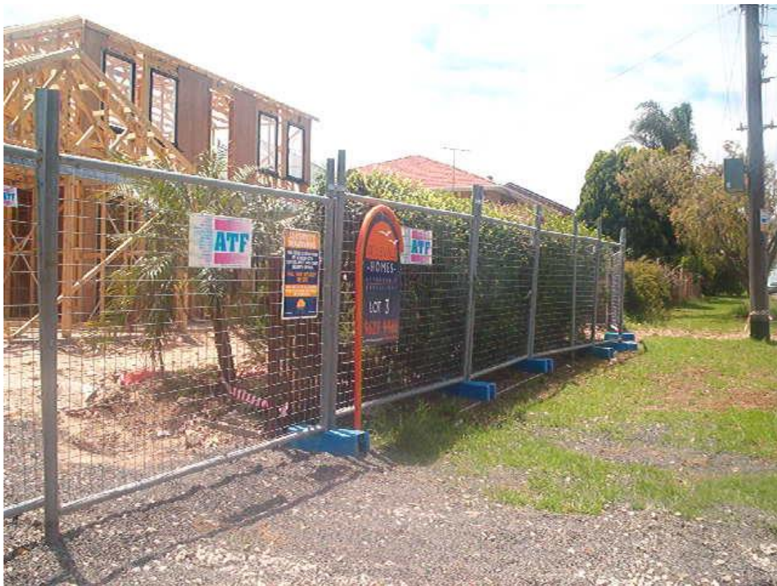
Εικόνα 1. Προσωρινή περίφραξη σε εργοτάξιο στο Σύδνεϋ της Αυστραλίας
