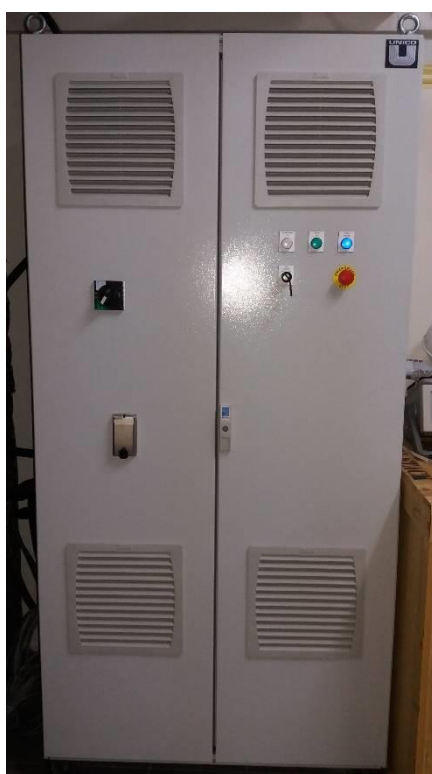
Εικόνα 2.9 – Το Inverter του δυναμόμετρου
