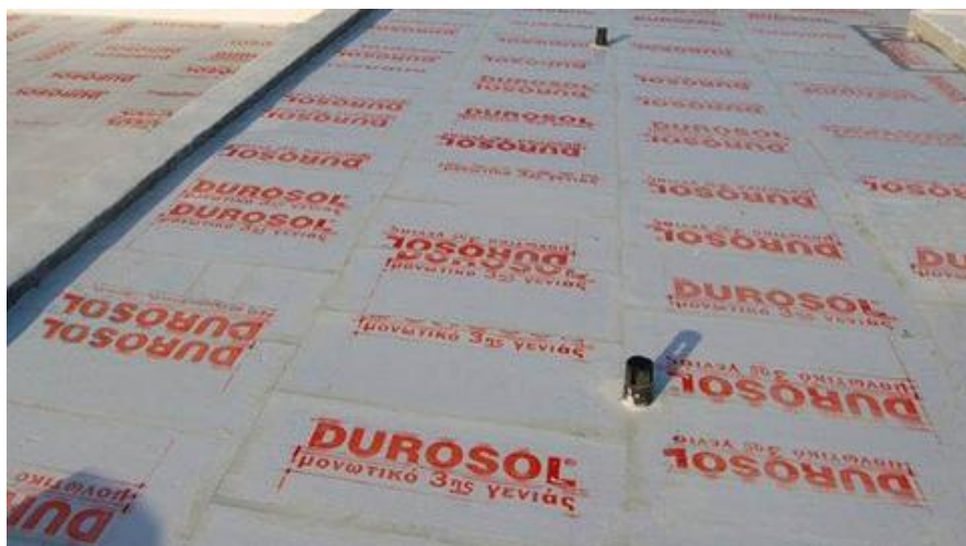
Εικόνα 5.10: Θερμομονωτικές πλάκες τοποθετημένες σε δώμα κτηρίου, πηγή: [FRAGOULAKIS].
