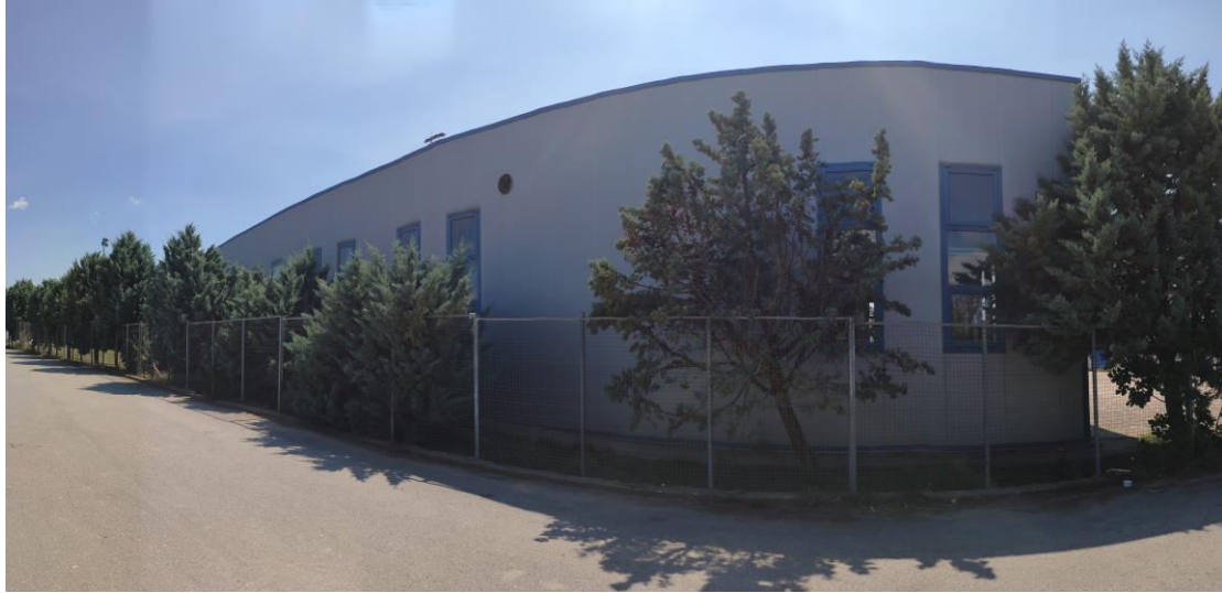
Εικόνα 3.5. Ανατολική όψη του κολυμβητηρίου
