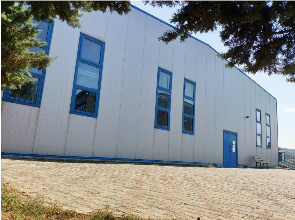
Εικόνα 3.3. Βόρεια όψη του κολυμβητηρίου
