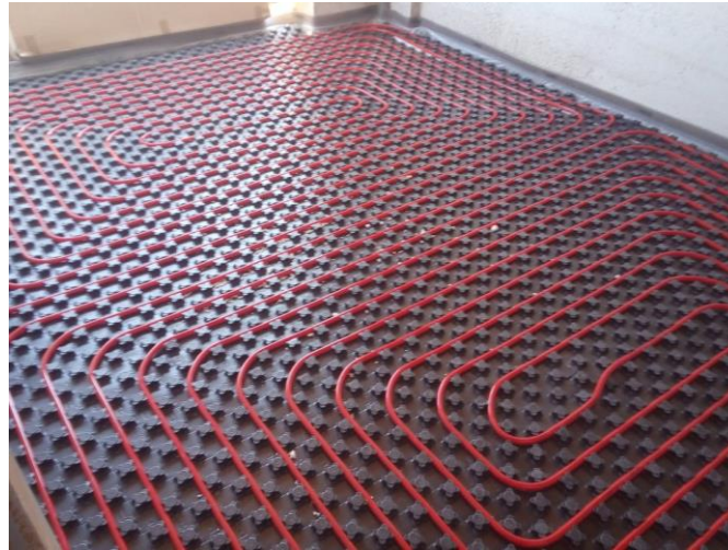
Σχήμα 1.8 Ενδοδαπέδια θέρμανση
