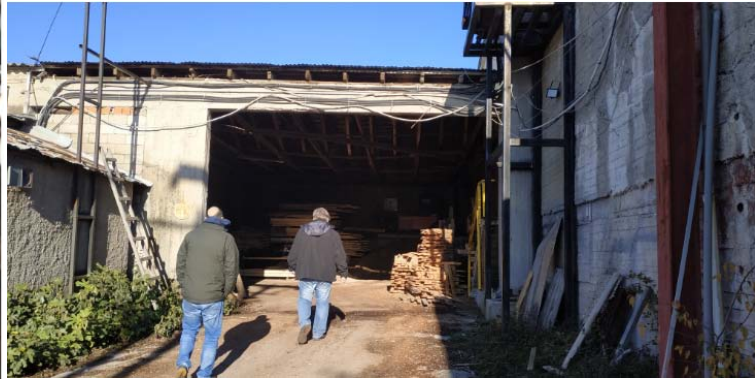
Εικόνα 2.15 : Γενική άποψη κτιρίου Β΄
