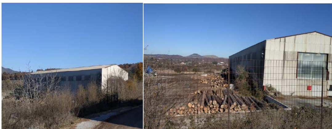
Εικόνα 2.8: Κτίριο υποδοχής κορμών
