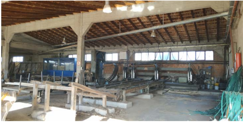
Εικόνα 2.10: Εσωτερικό κτιρίου Β
