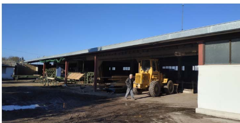
Εικόνα 2.9: Γενική άποψη κτιρίου Β
