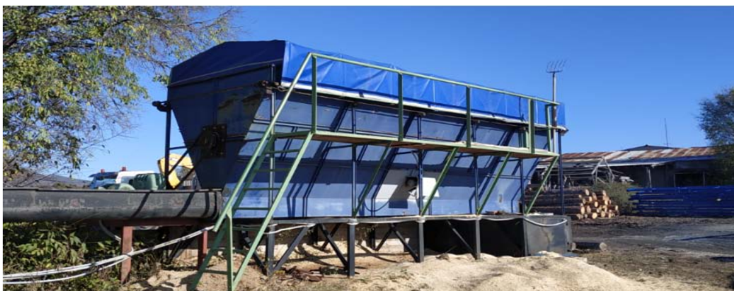
Εικόνα 2.20 : Σιλό τροφοδοσίας καύσιμης ύλης στον λέβητα
