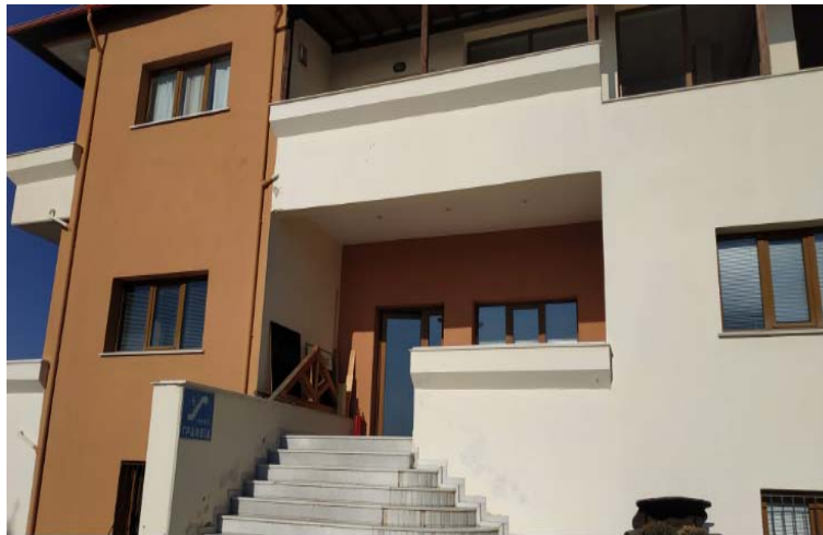
Εικόνα 2.7: Είσοδος γραφείων βιομηχανίας
