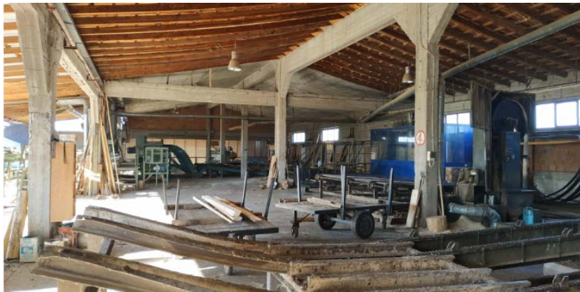
Εικόνα 2.11 : Εσωτερικό κτιρίου Β
