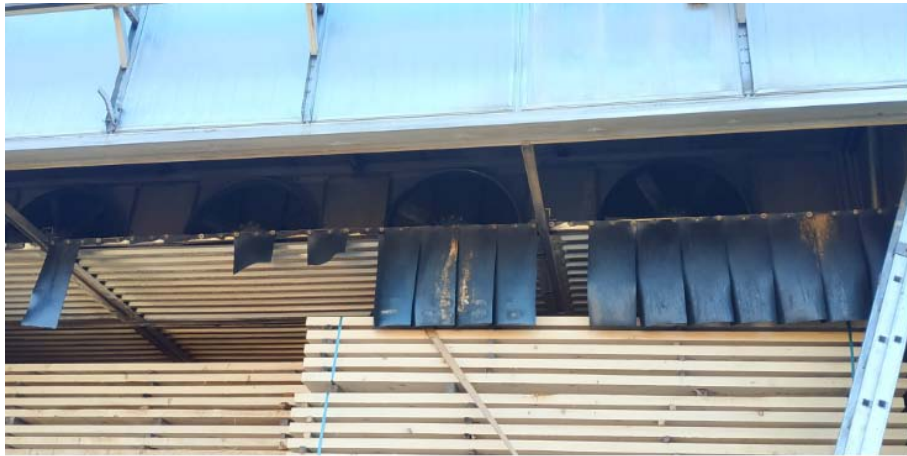
Εικόνα 2.26 : 4 fan coil για διοχέτευση ατμού
