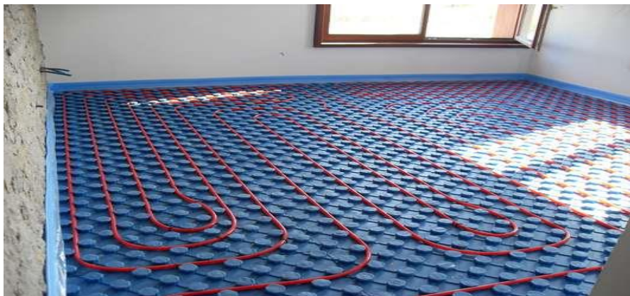
Εικόνα 4.6 Τυπική διάταξη σωληνώσεων ενδοδαπέδιας θέρμανσης ( ANDRIANOS, 2021 ).
