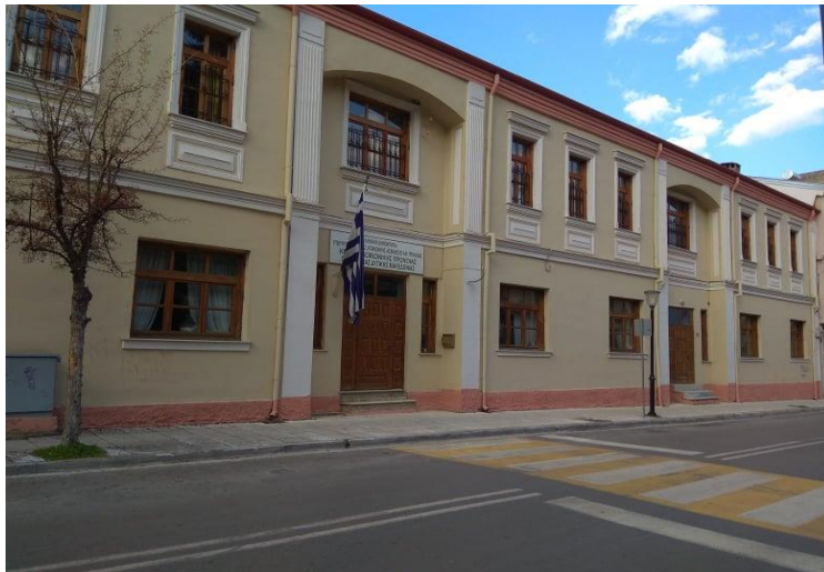
10. Κτίριο οικοτροφείου που στεγάζει υπηρεσίες του Κέντρου Κοινωνικής Πρόνοιας
