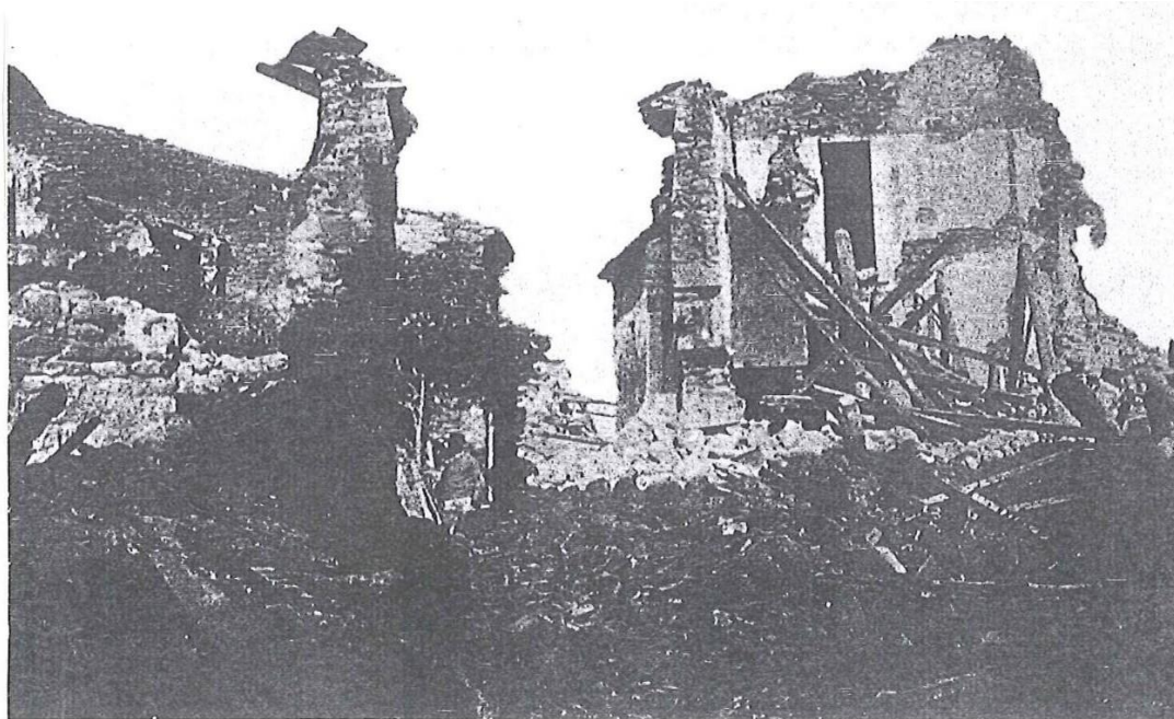
Τοίχοι σπιτιών μετά τη φωτιά Πηγή: Γιώργος Αναστασιάδης, ό.π., σ.269
