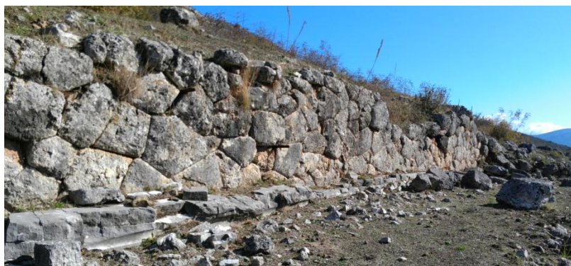
Ο αναλληματικός τοίχος της στοάς και το λίθινο θρανίο
