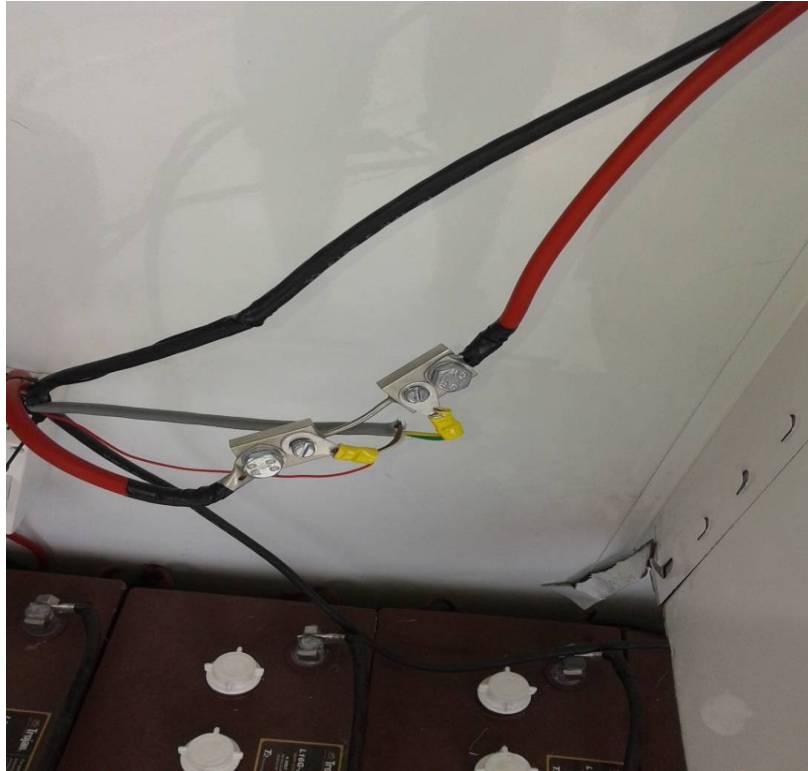
Σχήμα 3.12: Shunt ρεύματος.
