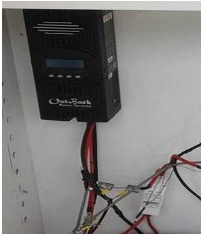
Σχήμα 3.5: Ελεγκτής φόρτισης (controller).
