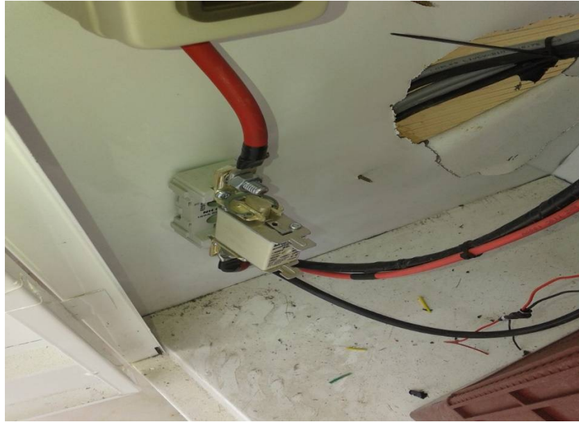
Σχήμα 3.14: Ηλεκτρική ασφάλεια (fuse).
