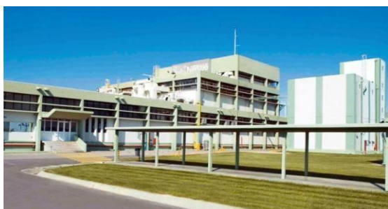
«Εργοστάσιο στα Οινόφυτα»,
