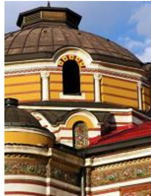
Το Ορεικό Λουτρό: Το Ορεικό Λουτρό ή αλλιώς όπως είναι γνωστό το Τουρκικό Λουτρό βρίσκεται στη Σόφια και ολοκληρώθηκε το 1913. Η εντυπωσιακή κομψή κεραιμή διακόσμηση τους προσελεί θαυμασμό στους τουρίστες αλλά και στους ντόπιους ακόμα. Εχοντας επέλθει πλήρης ανακατασκευή, το κτίριο τώρα φιλοξενεί παραστασιακές εκθέσεις έργων τέχνης.
