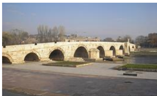
Η πέτρινη γέφυρα των Σκοπίων , με μήκος 314 μέτρα, πλάτος 5 μέτρα και 12 κολώνες, συνδέει το κέντρο των Σκοπίων με την παλιά πόλη, περνώντας πάνω από τον παλιό Αχός (Βασίτσα). Αποτελεί το σύμβολο των Σκοπίων και έχει συμπεριληφθεί στο θησαυρό της πόλης. Σύμφωνα με τις περισσότερες πηγές κατασκευάστηκε το 15ο αιώνα και καταστράφηκε πολλές φορές όπως κατά το σεισμό του 1555 από τον οποίο έπαθαν σοβαρές ζημιές τρεις φορές από τις καταιγίδες του.
