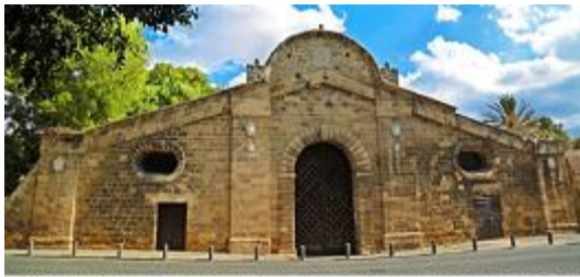
Η Πύλη Αμμουκλετών, η πιο σπουδαία από τις πύλες της Ενετικής Λευκωσίας, άνοιξε στο δρόμο που οδηγούσε στο πιο σημαντικό λιμάνι του νησιού, στην Αμμώκλιση, από όπου πήρε και το όνομά της. Αρχικά (πριν γινεί) σαν Πύλη Τριουλίου προς τιμήν του Giulio Savorgnano, του μηχανικού που σχεδίασε και έχτισε τα Ενετικά τείχη στον 16ο αιώνα.
