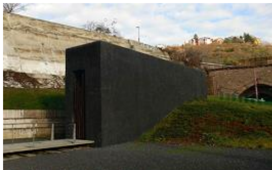
Το μνημείο Chatham Sofer , πρώην Παλαιό Εβραϊκό Νεκροταφείο, είναι ο τόπος ταφής και μνημείο του Μωυσή Σοφί, ενός εξέχοντα ραββίνου του 19ου αιώνα που χιτίστηκε στη θύρα ενός εβραϊκού νεκροταφείου του 17ου αιώνα στη Μπράτισλαβα της Σλοβακίας.
