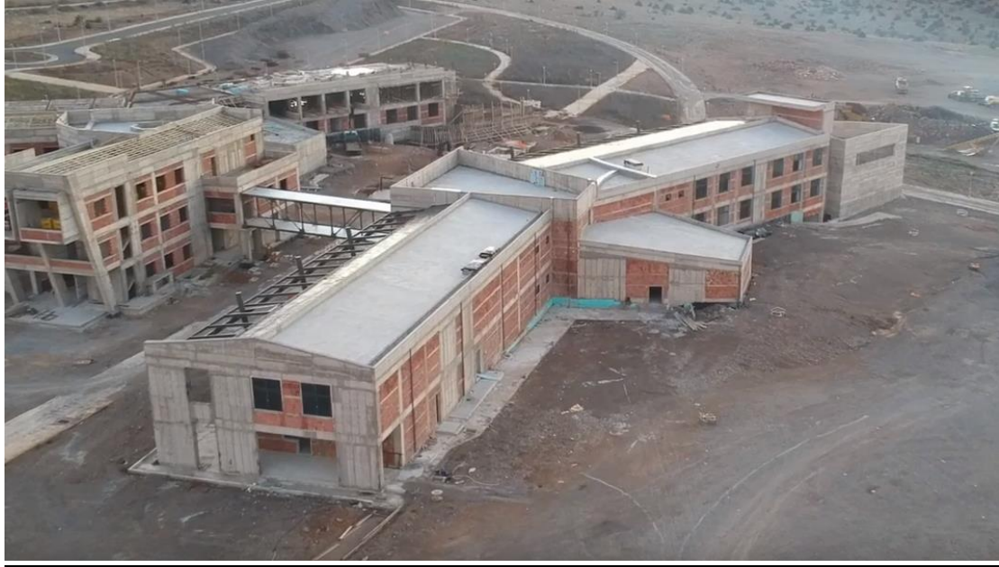
Εικόνα 19 Πραγματική εικόνα της υπό κατασκευής Πανεπιστημιούπολης
