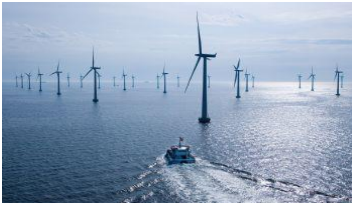
Εικόνα : London Array το μεγαλύτερο υπεράκτιο αιολικό πάρκο στον κόσμο
