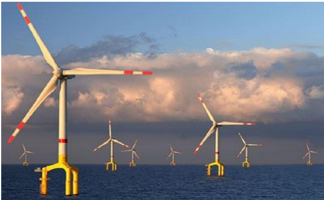
Εικόνα : Υπεράκτιο αιολικό πάρκο στην Γερμανία
