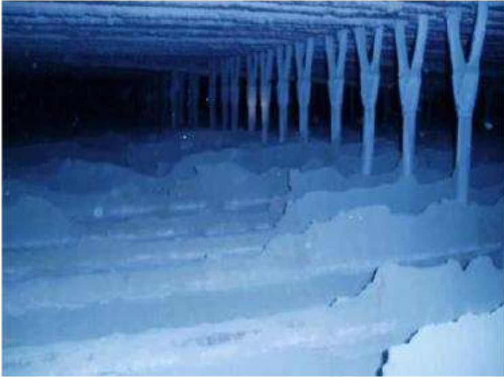
Εικόνα 11-48 : Επικαθίσεις μεταξύ SH1b (Πάνω) και RH2 (Κάτω) (Ύψος 53,500 m)
