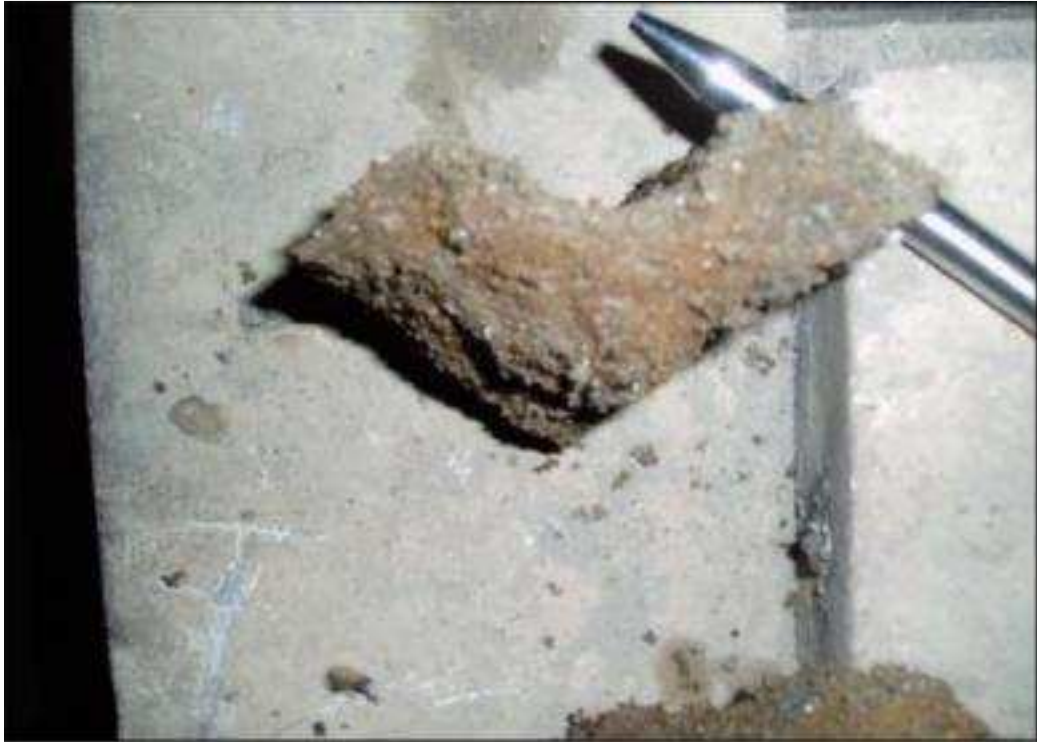
Εικόνα 11-19 : Επικάθιση από υδρότοιχο με Αποτύπωμα Αυλού (1)
