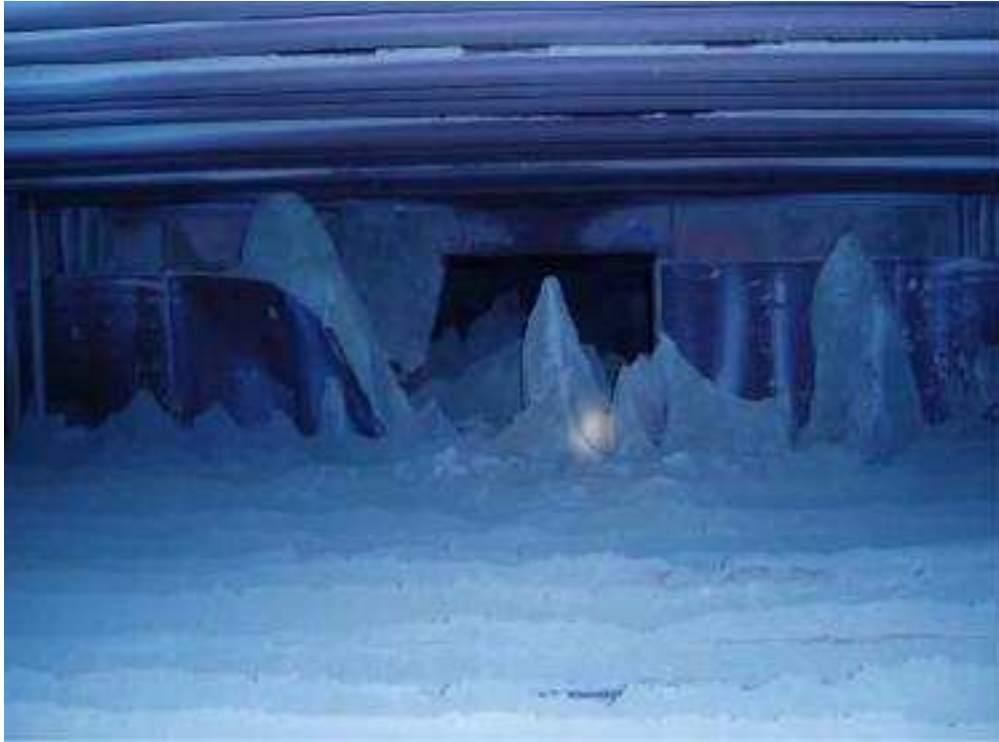
Εικόνα 11-36 : Όψη μεταξύ SH1a (Πάνω) και RH1b (Κάτω) (Ύψος 58,170 m)
