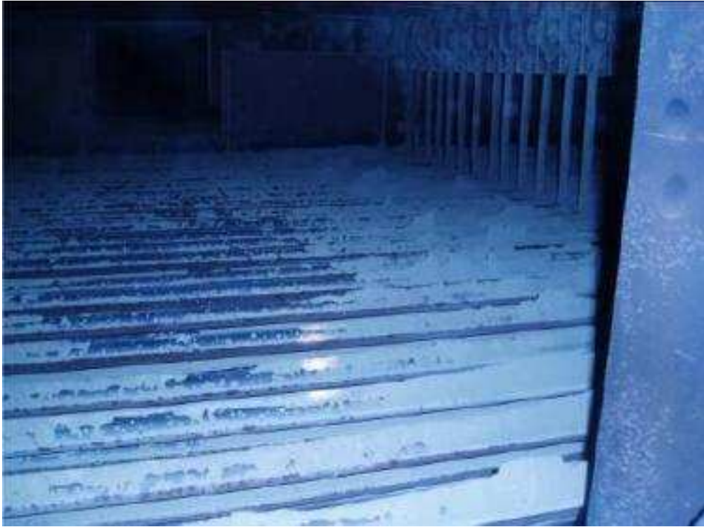
Εικόνα 11-25 : Οικονομητήρας, Ενδιάμεσα Άνω και Κάτω Αυλών (Ύψος 66,420 m)
