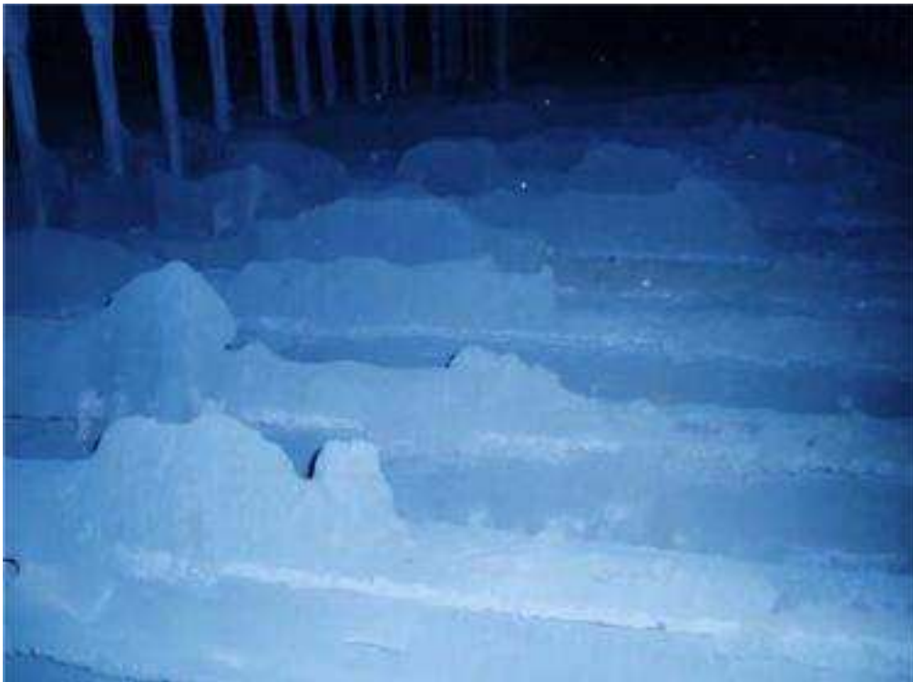
Εικόνα 11-47 : Επικαθίσεις στο Άνω Τμήμα του RH2 (Ύψος 53,500 m)
