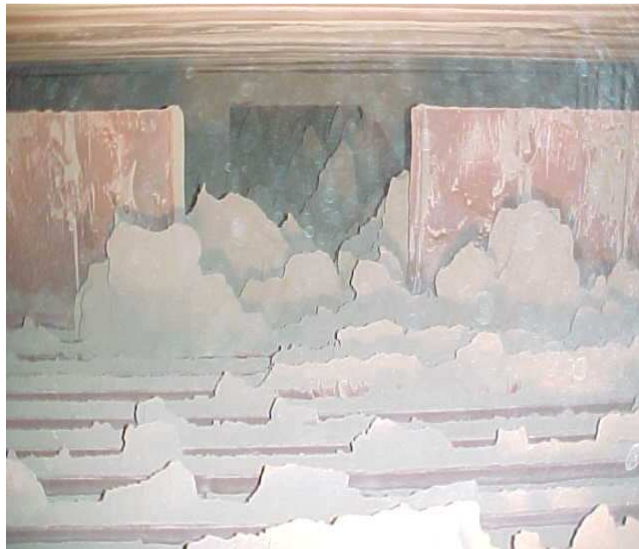
Εικόνα 1-1 : Σχηματισμός επικαθίσεων τέφρας στους υπερθερμαντές
