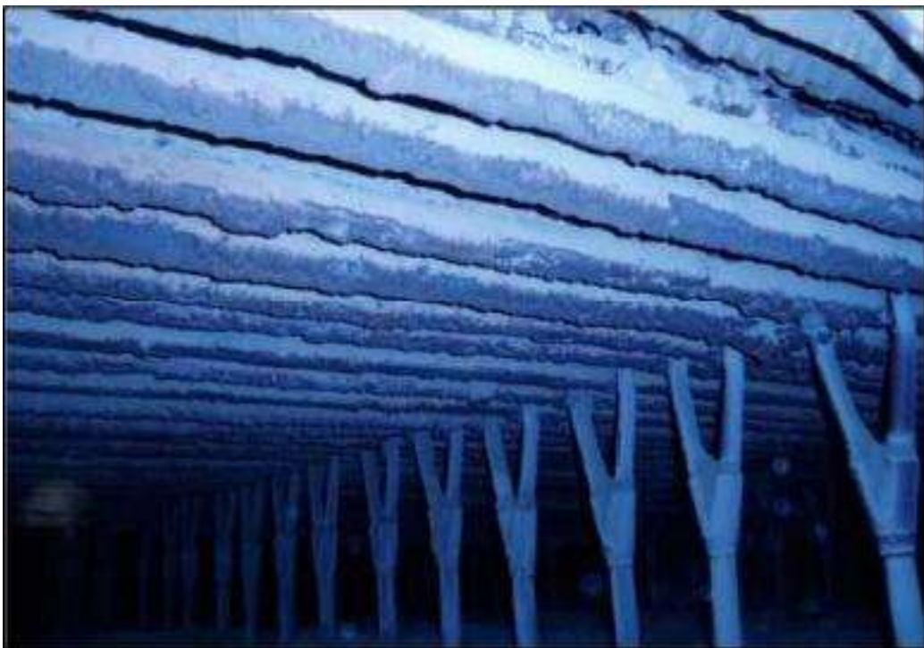
Εικόνα 11-14 : Υ/Θ 1α, κάτω σωλήνας με σκληρές επικαθίσεις. Ύψος 68.170 Μέτρα
