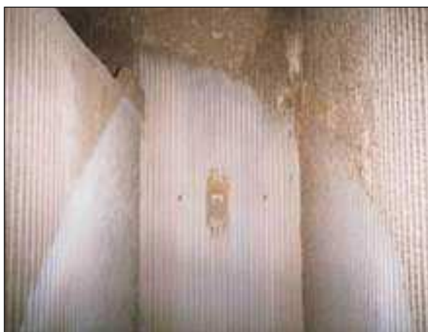
Εικόνα 18-3 : Επιφάνεια υδρότοιχου καθαρισμένη με watercannon
