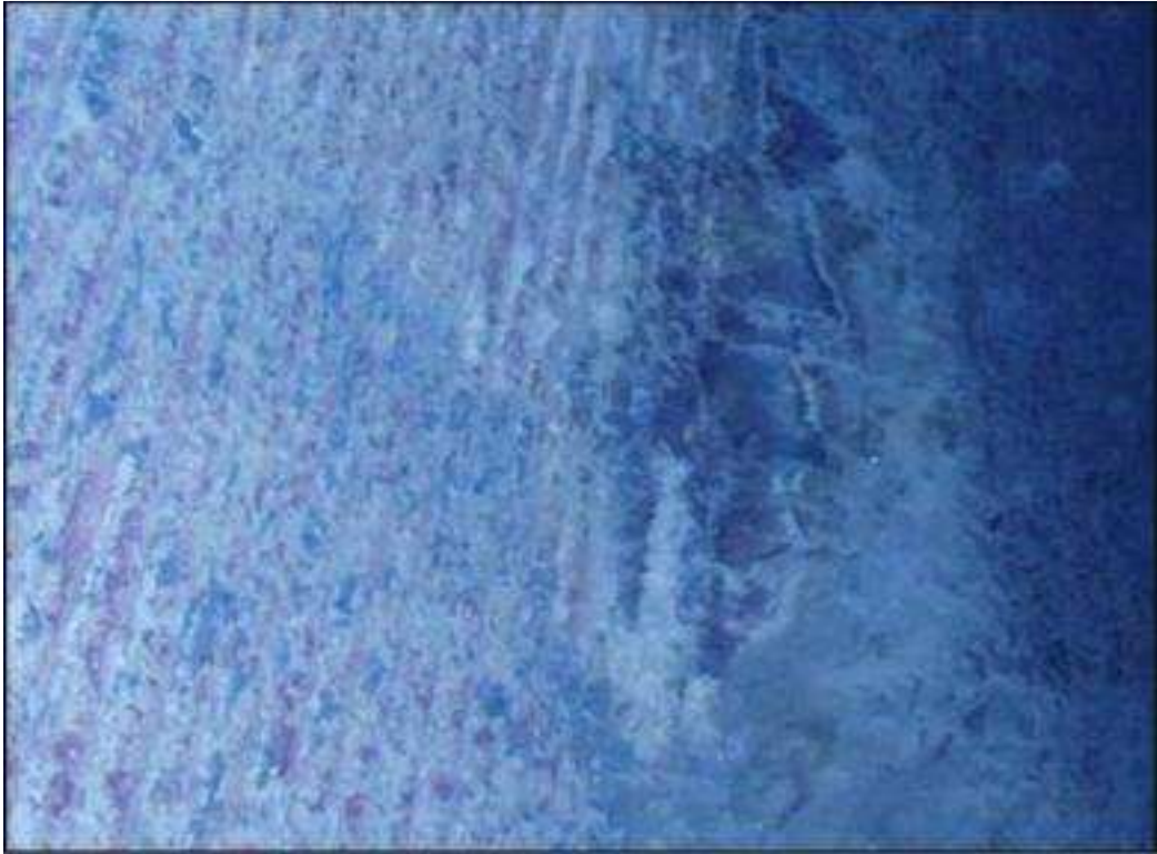
Εικόνα 11-7 : Εμπρόσθιος υδρότοιχος καθαρός (αριστερά) με επικάθιση (δεξιά). Ύψος 26 Μέτρα
