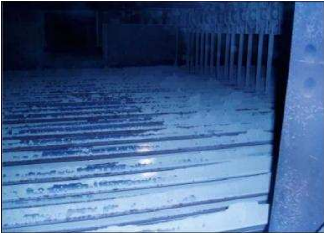
Εικόνα 11-11 : Οικονομητήρας. Ύψος 66.420 Μέτρα
