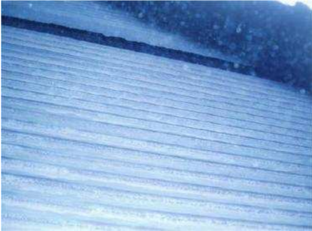
Εικόνα 11-64 : Επικαθίσεις στο Κάτω Μέρος του SH3 (Ύψος 47,045 m)
