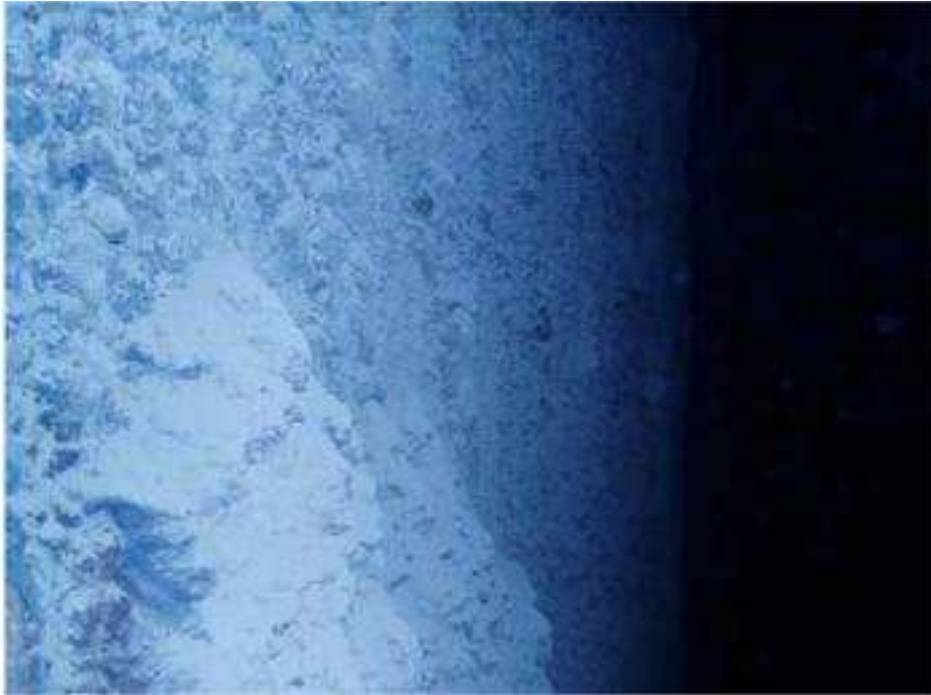
Εικόνα 11-80 : Πάνω τμήμα επικάλυψης στον εμπρόσθιο υδρότοιχο (Ύψος 26m)
