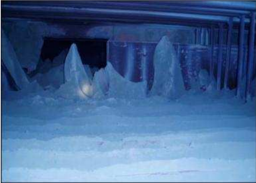
Εικόνα 11-13 : Λήψη μεταξύ Υ/Θ 1α (επάνω) και Α/Θ 1β (κάτω) με μεγάλες συσσωματώσεις που φτάνουν σε ύψος τα 80 εκατοστά. Ύψος 58.170 Μέτρα
