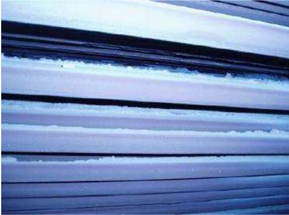
Εικόνα 11-34 : SH1a (Κάτω Τμήμα) (Ύψος 58,170 m)
