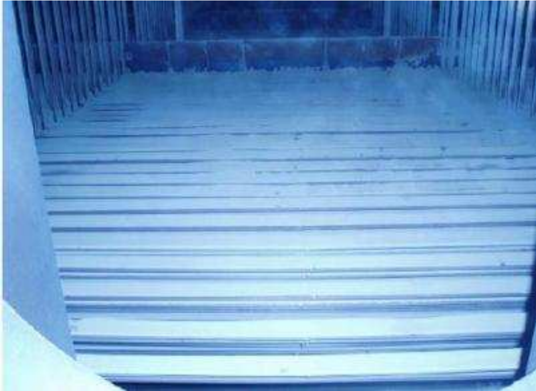
Εικόνα 11-23 : Οικονομητήρας, Πάνω Μέρος (Ύψος 60,00 m)
