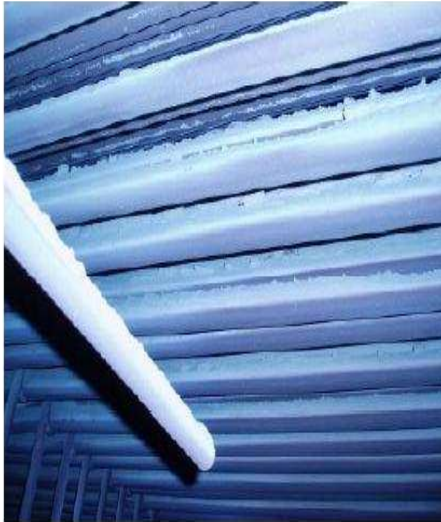
Εικόνα 11-33 : SH1a (Κάτω Τμήμα) (Ύψος 58,170 m)
