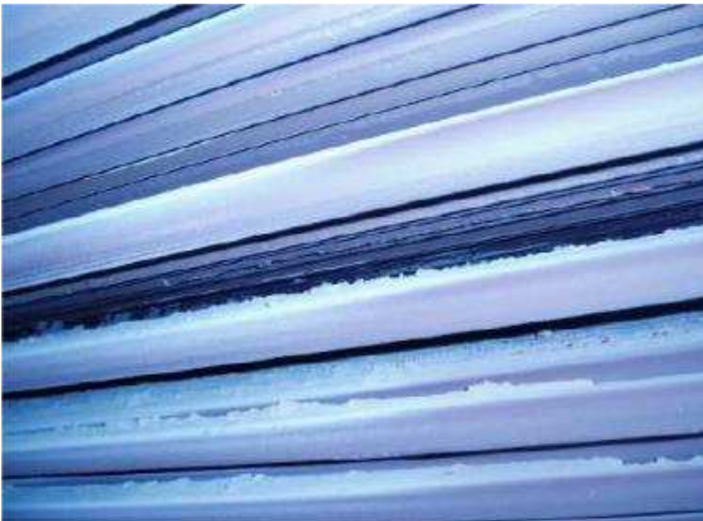
Εικόνα 11-35 : SH1a (Κάτω Τμήμα) (Ύψος 58,170 m)
