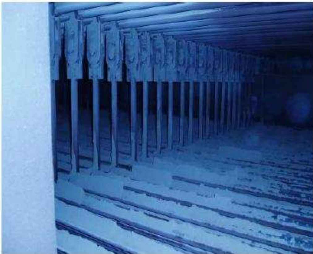
Εικόνα 11-26 : Οικονομητήρας, Ενδιάμεσα Άνω και Κάτω Αυλών (Ύψος 66,420 m)
