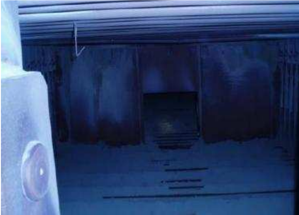
Εικόνα 11-29 : Οικονομητήρας (Πάνω) και RH1a (Κάτω) (Ύψος 63,540 m)
