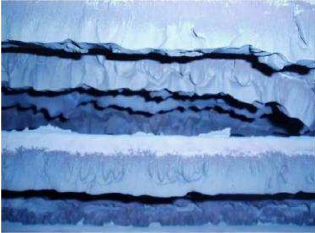
Εικόνα 11-46 : Επικαθίσεις στους Αυλούς στο Κάτω Μέρος του SH1b (Ύψος 53,500 m)
