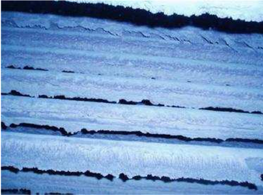
Εικόνα 11-60 : Επικαθίσεις στο Κάτω Μέρος του SH3 (Ύψος 47,045 m)
