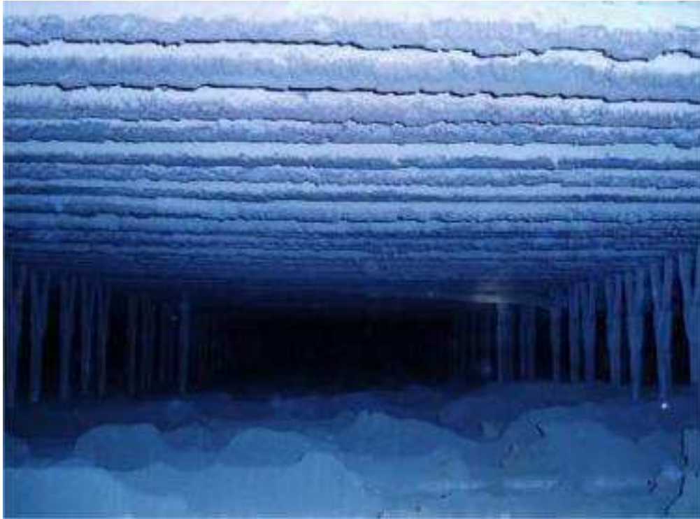
Εικόνα 11-44 : Όψη μεταξύ SH1b (Πάνω) και RH2 (Κάτω) (Ύψος 53,500 m)
