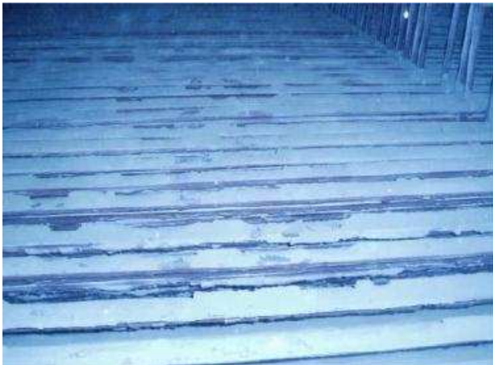
Εικόνα 11-41 : SH1b, Πάνω Τμήμα (Ύψος 55,820 m)
