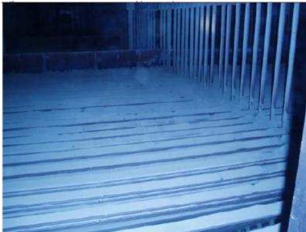
Εικόνα 11-24 : Οικονομητήρας, Πάνω Μέρος (Ύψος 60,00 m)
