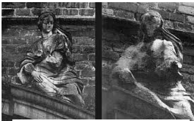
Εικόνα 36 - Οι επιδράσεις της όξινης βροχής σε υλικά και κτίρια
