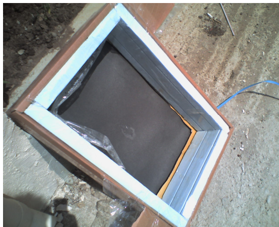
Σχήμα 8.1: Εσωτερική όψη της δοκιμαστικής κατασκευής.
