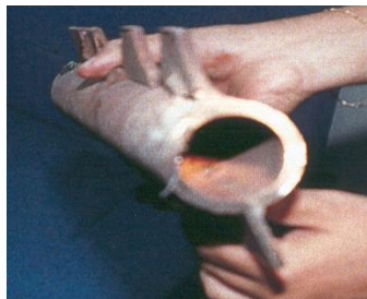
Εικόνα 12 – τμήμα σε συνέχεια του διαβρωμένου τμήματος αυλού οροφής στα +41 m
