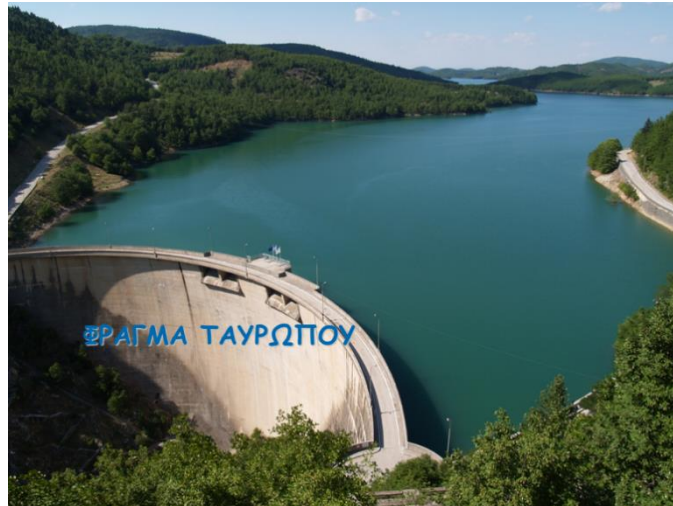
Σχήμα 2 : Φράγμα ΥΗΣ Ταυρωπού
