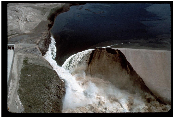
Σχήμα 7: Διάρρηξη φράγματος Teton
