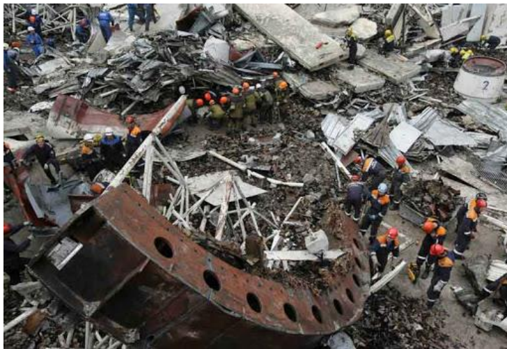
Σχήμα 9: καταστροφή τουρμπίνας στον ΥΗΣ Sayano Shushenskaya (Ρωσία)
