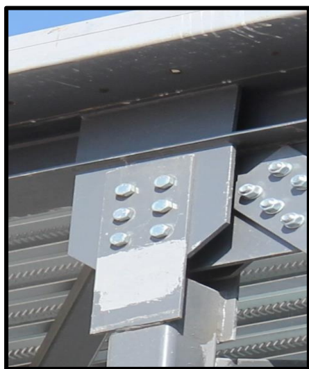
Εικόνα 2.4: Απεικόνιση σύνδεσης κάθετων κοιλοδοκών και δοκών τύπου Η μέσω των συμπαγών ελασμάτων
