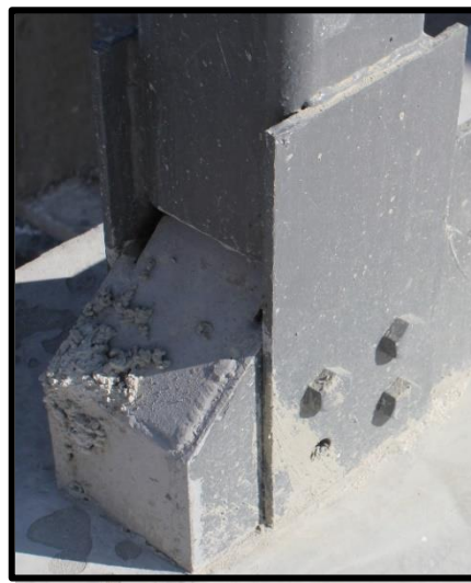
Εικόνα 2.4: Απεικόνιση σύνδεσης κάθετων κοιλοδοκών και δοκών τύπου Η μέσω των συμπαγών ελασμάτων
