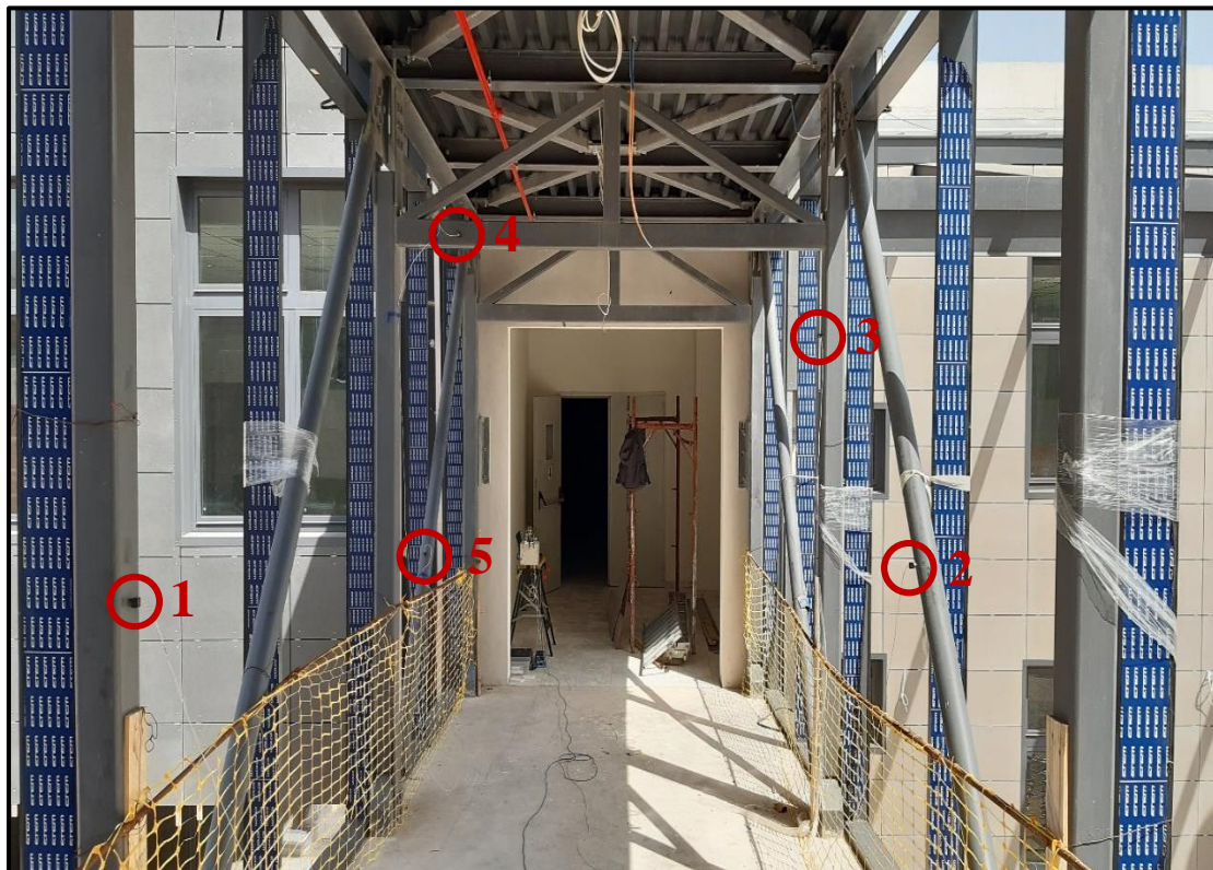
Εικόνα 5.6: Τοποθέτηση επιταχυνσιόμετρων στον σκελετό της κατασκευής
