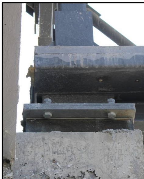
Εικόνα 2.8: Απεικόνιση πρόσδεσης της κατασκευής
