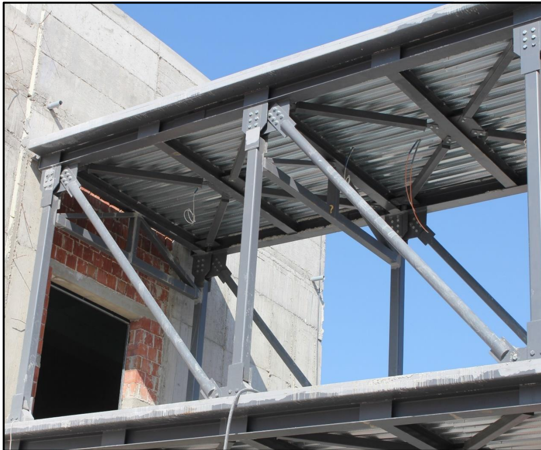
Εικόνα 2.7: Απεικόνιση κυκλικών κοιλοδοκών
