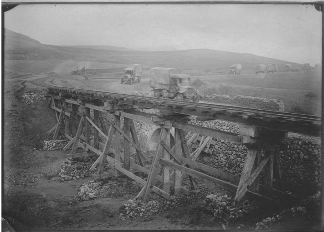
Εικόνα 17: Η σιδηροδρομική γραμμή Ξινού Νερού (Δεκέμβριος 1916). Γέφυρα Decauville στο Ξινό Νερό (Ministry of Culture (France), Multimedia library of architecture and heritage, distribution RMN-GP, 2020).
