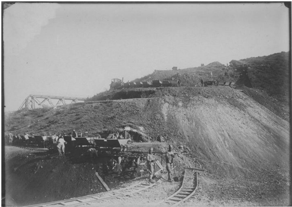
Εικόνα 16: Η σιδηροδρομική γραμμή Ξινού Νερού (Δεκέμβριος 1916). Απόκλιση του Ξινού Νερού: Δημιουργία της νέας σιδηροδρομικής γραμμής (Ministry of Culture (France), Multimedia library of architecture and heritage, distribution RMN-GP, 2020).
