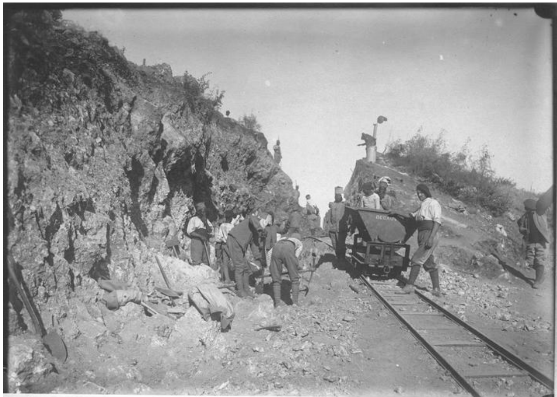
Εικόνα 36: Απόκλιση του Ξινού Νερού: Δημιουργία της νέας σιδηροδρομικής γραμμής (Ministry of Culture (France), Multimedia library of architecture and heritage, distribution RMN-GP, 2020).
