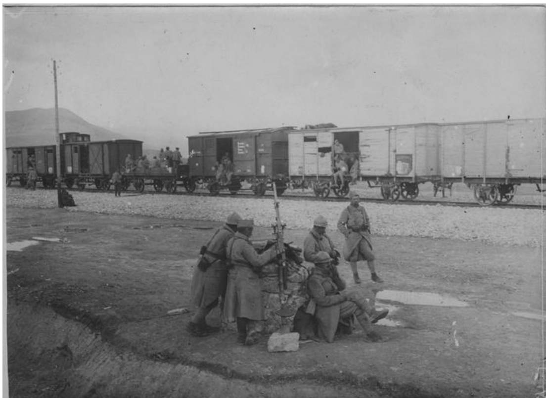
Εικόνα 42: Η σιδηροδρομική γραμμή Ξινού Νερού (Δεκέμβριος 1916). Σταθμός πολυβόλων μετρητών αεροσκαφών εγκατεστημένος στον ίδιο τον σταθμό (Ministry of Culture (France), Multimedia library of architecture and heritage, distribution RMN-GP, 2020).
