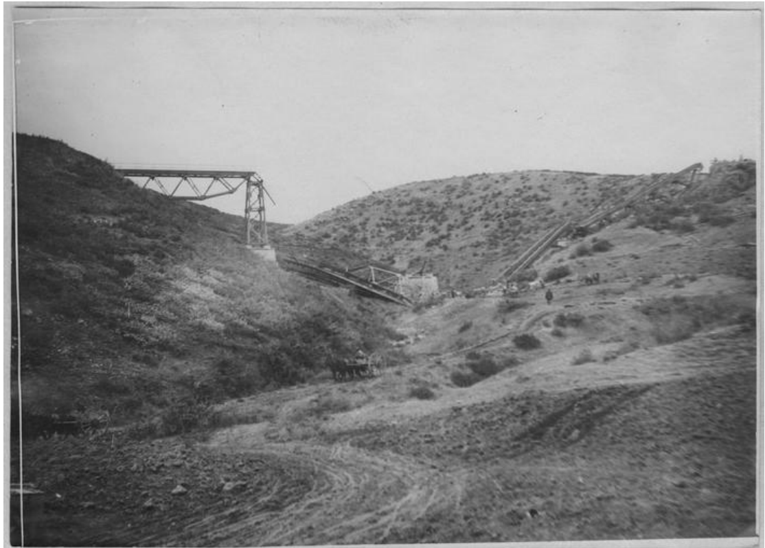
Εικόνα 34: Οκτώβριος 1916. Η οδογέφυρα του Ξινού Νερού καταστράφηκε από τους Βούλγαρους στην υποχώρησή τους (Ministry of Culture (France), Multimedia library of architecture and heritage, distribution RMN-GP, 2020).
