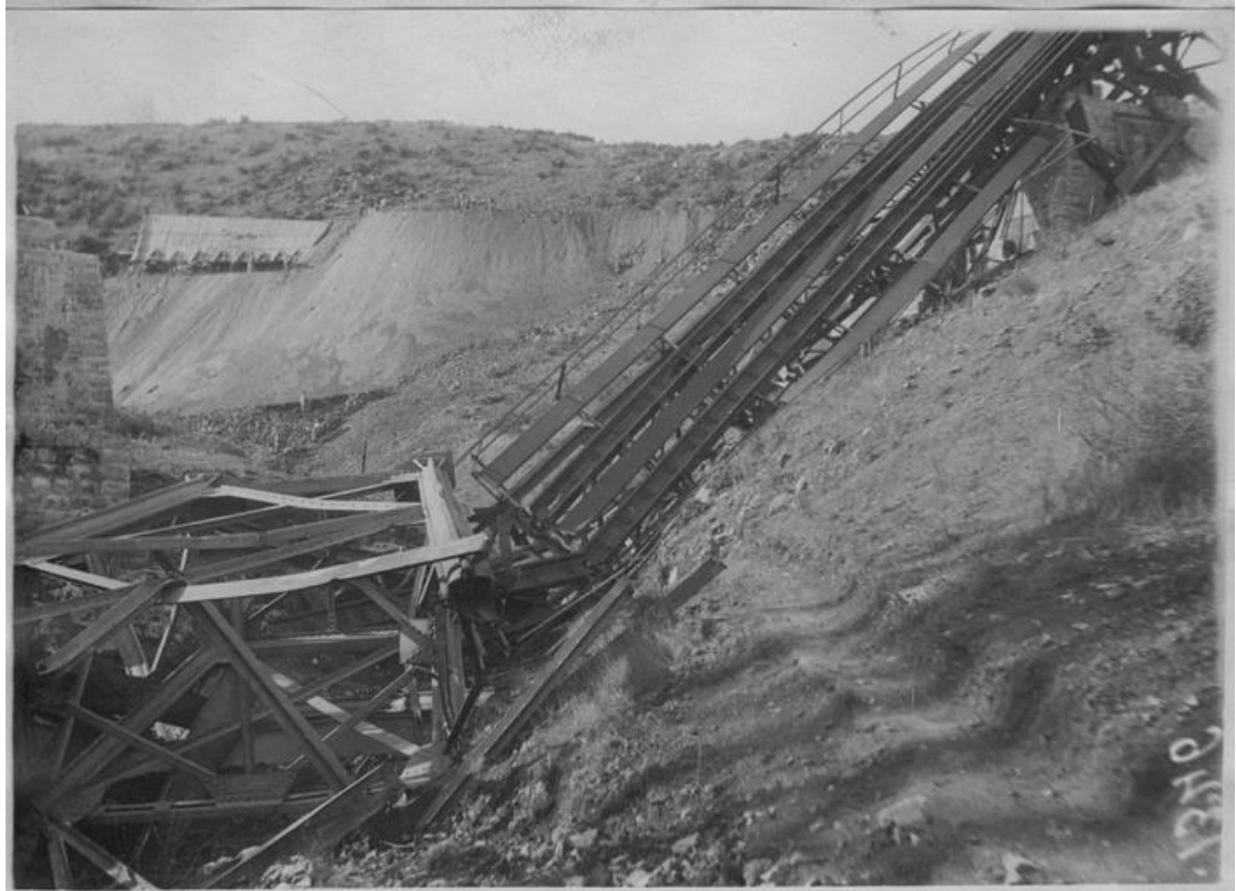
Εικόνα 25: Οκτώβριος 1916. Η οδογέφυρα του Ξινού Νερού καταστράφηκε από τους Βούλγαρους στην υποχώρησή τους (Ministry of Culture (France), Multimedia library of architecture and heritage, distribution RMN-GP, 2020).
