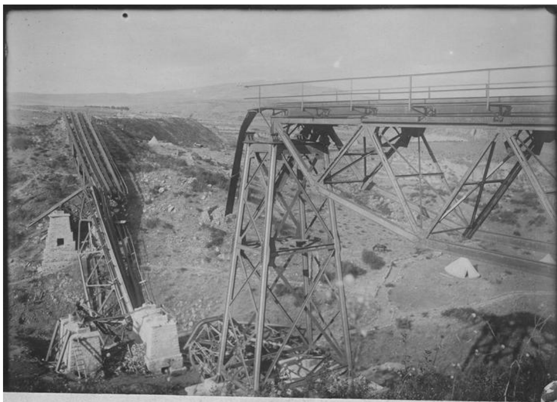
Εικόνα 23: Η σιδηροδρομική γραμμή Ξινού Νερού (Δεκέμβριος 1916). Η γέφυρα Ξινού Νερού καταστράφηκε από τους Βούλγαρους (Ministry of Culture (France), Multimedia library of architecture and heritage, distribution RMN-GP, 2020).
