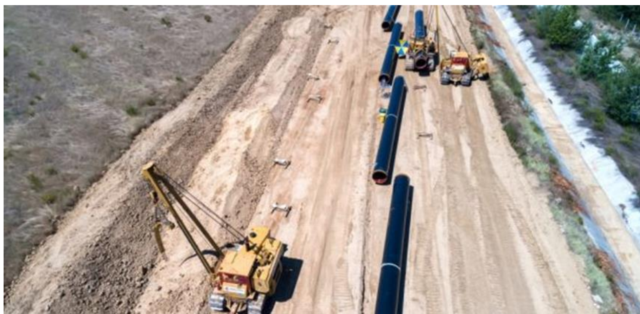
Εικόνα 2-8. Τοποθέτηση αγωγών φυσικού αερίου στη Δυτική Μακεδονία. (Νέους αγωγούς αερίου για τη Δυτική Μακεδονία και την Πάτρα μελετάει ο ΔΕΣΦΑ – Ετοιμάζει το νέο 10ετές αναπτυξιακό πρόγραμμα έργων, 2020)
