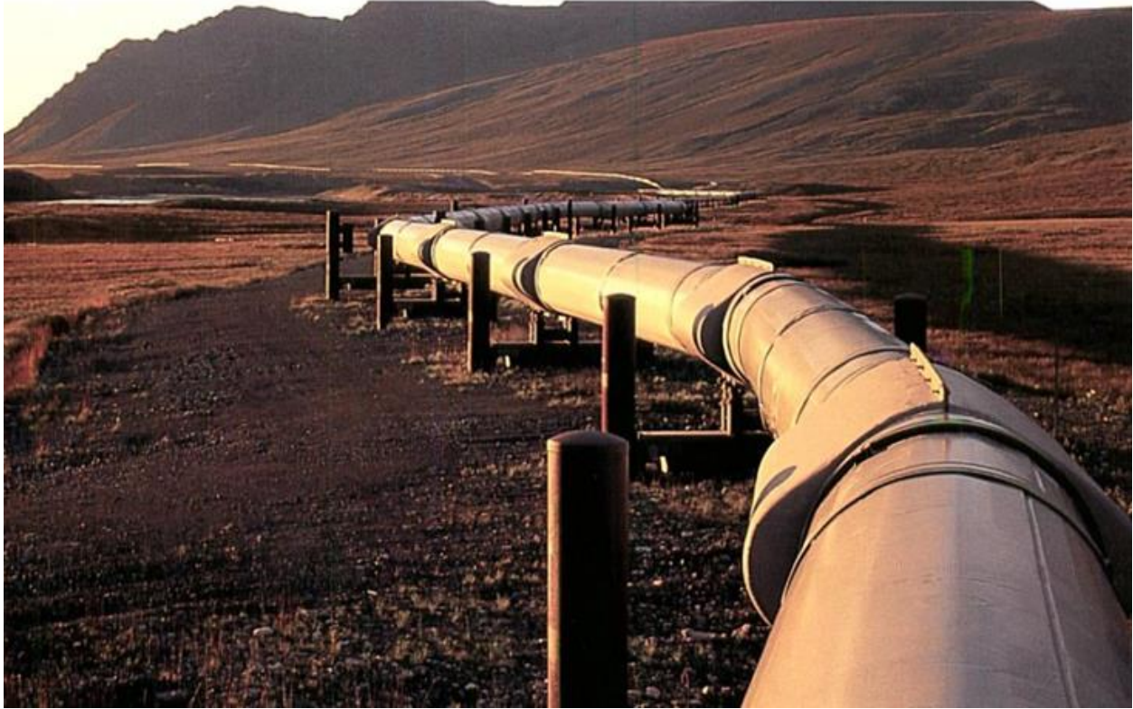
Εικόνα 2-6. Ο αγωγός TAP, μήκους περίπου 878 χλμ., συνδέεται με τον αγωγό Trans Anatolian Pipeline (TANAP) στους Κήπους στα ελληνοτουρκικά σύνορα. (Πρεμιέρα για τον αγωγό TAP που φέρνει το αζέρικο αέριο στην Ελλάδα, 2021)
