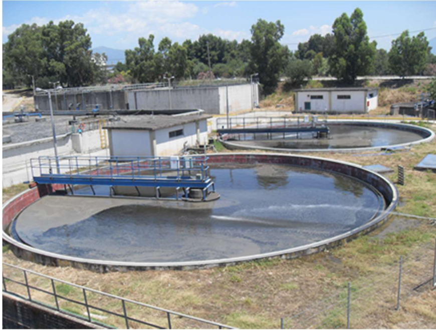
Σχήμα 2.5. Τυπική διάταξη μίας δεξαμενής καθίζησης.
