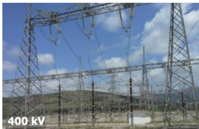
Σχήμα 3: Υποσταθμός AIS 400 kV.
