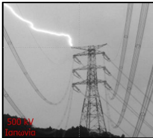
Σχήμα 26: Πλήγμα στον πυλώνα σε εναέρια γραμμή 500 kV στην Ιαπωνία [33].
