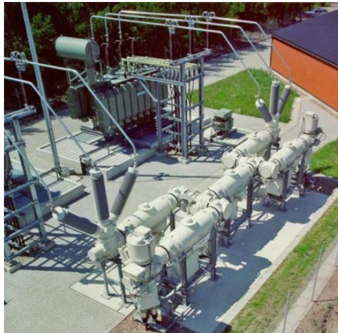
Σχήμα 6: Υποσταθμός MTS 145 kV [7].
