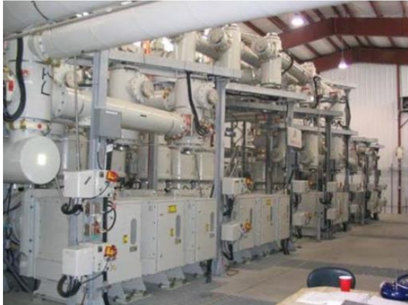
Σχήμα 5: Υποσταθμός GIS σε εσωτερικό χώρο [7].
