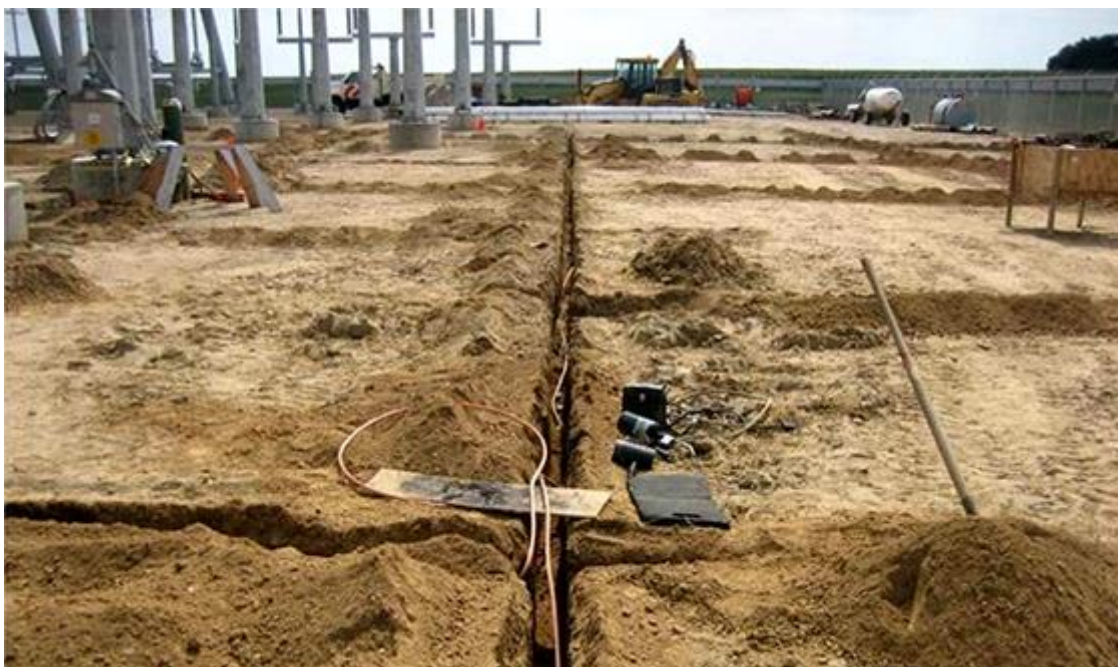
Σχήμα 24: Κατασκευή συστήματος γείωσης υποσταθμού [30].
