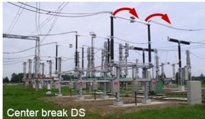
Σχήμα 14: Αποζεύκτης υποσταθμού AIS [16].
