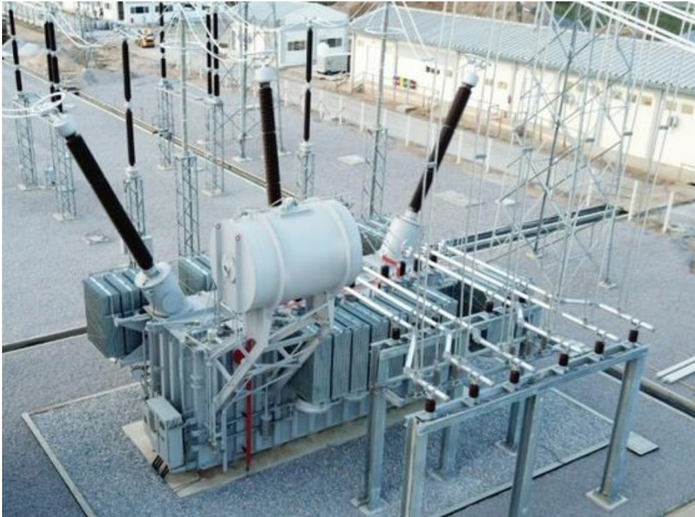
Σχήμα 10: Μετασχηματιστής Ισχύος [13].
