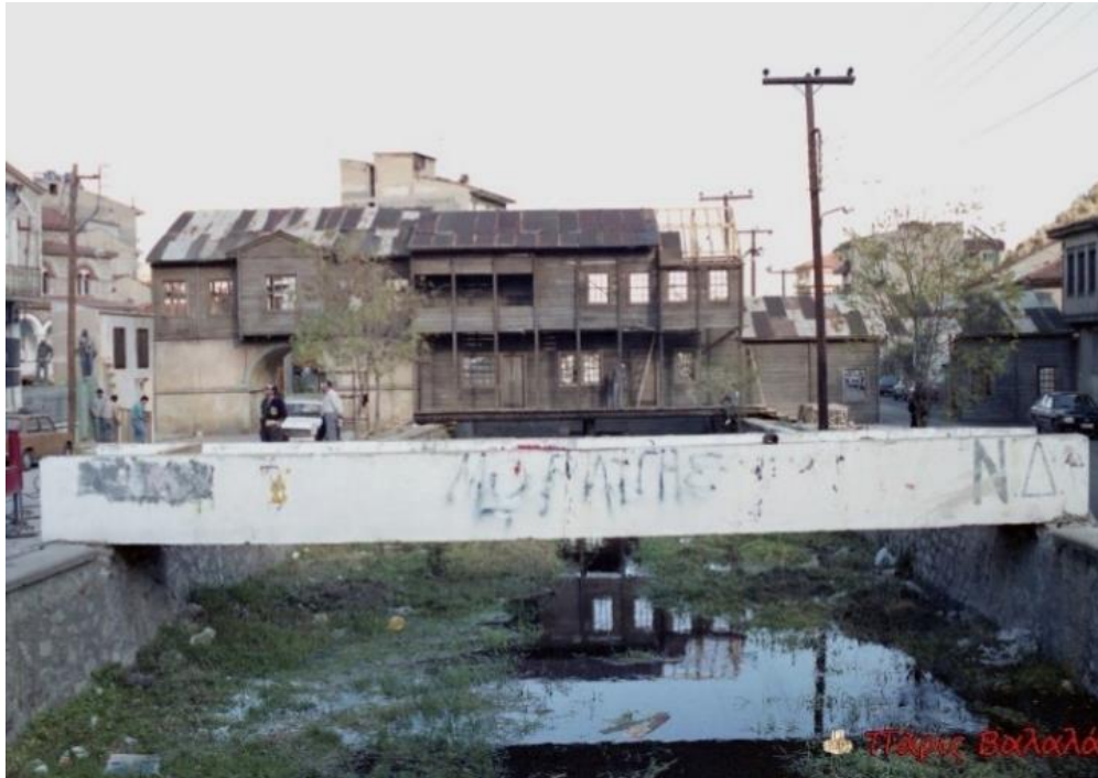
Εικόνα 12. Η γέφυρα στον ποταμό Σακουλέβα
